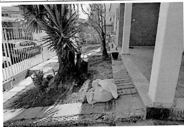
Foto 03 - Entrada principal / garagem
