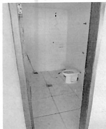
Foto 23 - Sanitario area posterior
