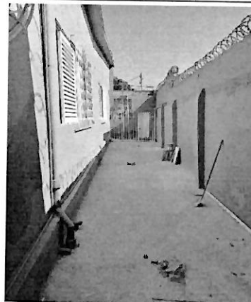
Foto 10 - Vista lateral area serviço
