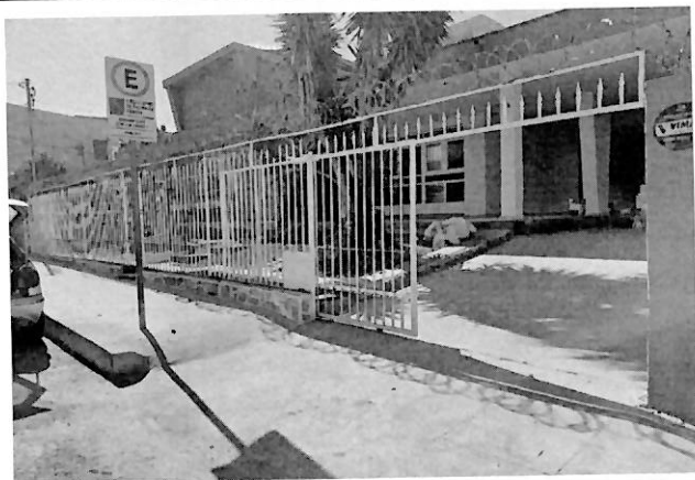
Foto 01 - Fachada entrada Garagem
