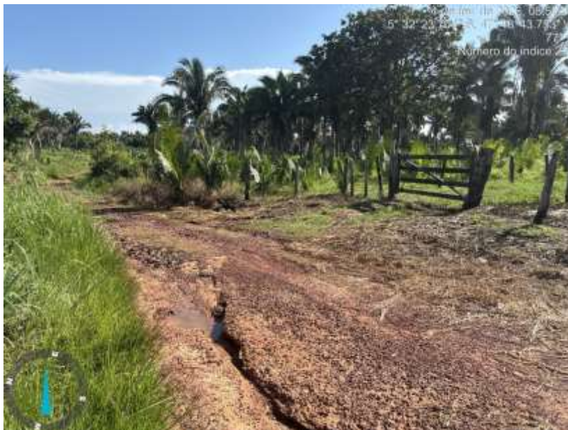
Foto 21: Situação do final do trecho da estrada que sofrerá intervenção
