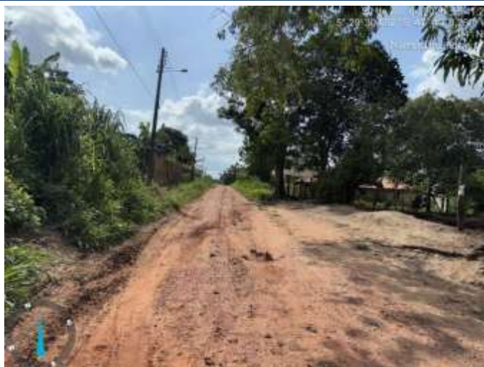
Foto 15: Situação do final da estrada que sofrerá intervenção
