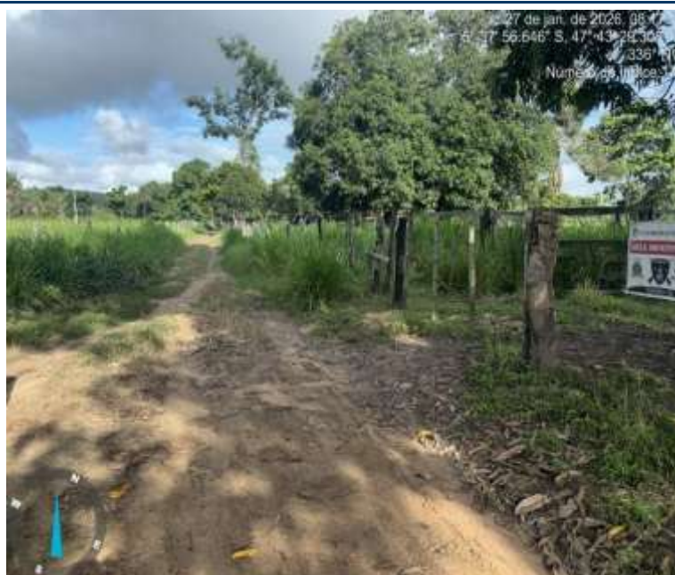
Foto 30: Situação do final do trecho da estrada que sofrerá intervenção
