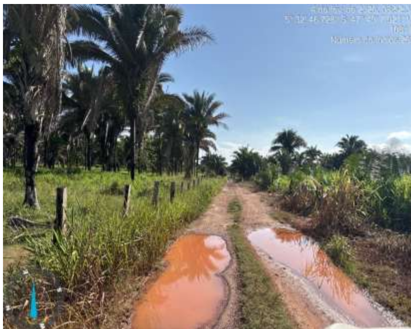
Foto 18: Situação do trecho meio da estrada que sofrerá intervenção
