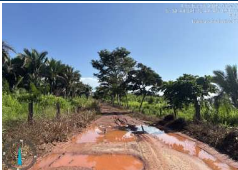
Foto 19: Situação no meio do trecho da estrada que sofrerá intervenção
