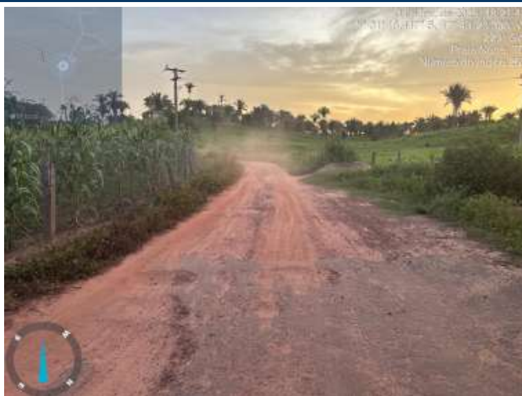
Foto 08: Situação do final da estrada que sofrerá intervenção
