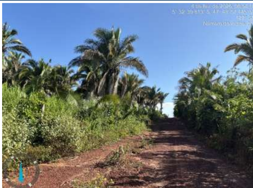
Foto 20: Situação no meio do trecho da estrada que sofrerá intervenção
