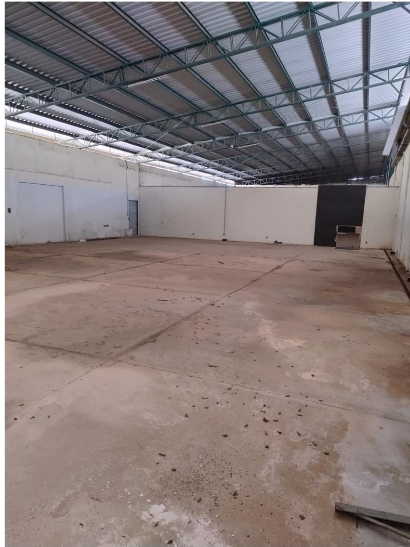
INTERIOR DA PRIMEIRA PARTE DO SEGUNDO GALPÃO
