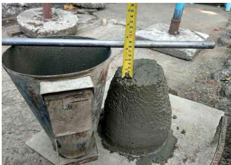
Detalhe da coleta de corpo de prova.
