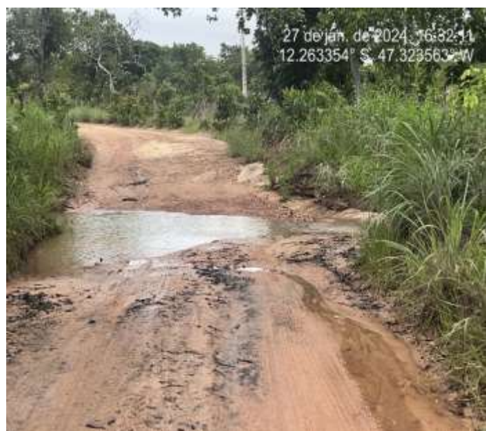
Figura 04: Instalação de bueiros simples e duplos na região dos Matões.
