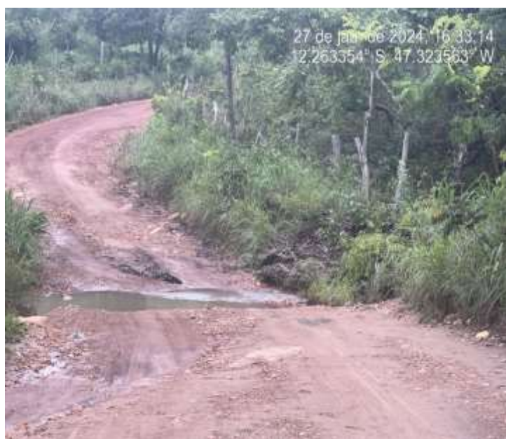
Figura 03: Instalação de bueiros simples e duplos na região dos Matões.
