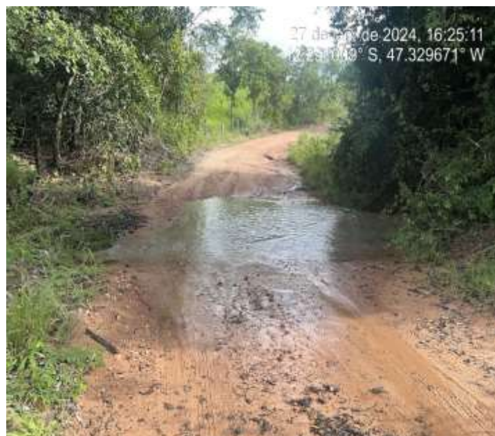
Figura 10: Instalação de bueiros simples e duplos na região dos Matões.
