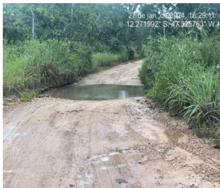
Figura 08: Instalação de bueiros simples e duplos na região dos Matões.
