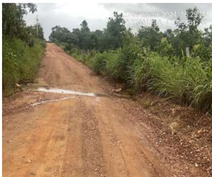
Figura 07: Instalação de bueiros simples e duplos na região dos Matões.
