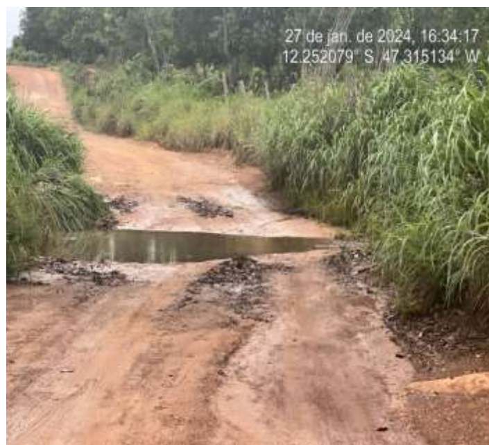
Figura 02: Instalação de bueiros simples e duplos na região dos Matões.
