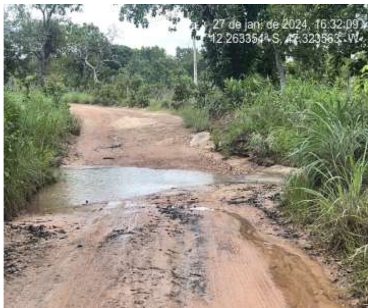
Figura 05: Instalação de bueiros simples e duplos na região dos Matões.
