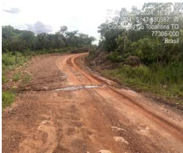
Figura 13: Instalação de bueiros simples e duplos na região dos Matões.
