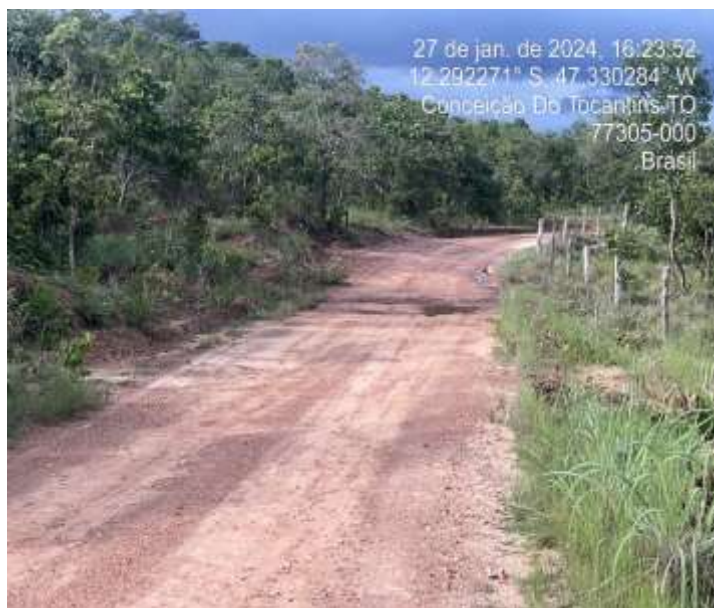
Figura 11: Instalação de bueiros simples e duplos na região dos Matões.
