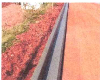
PADRÃO A SER SEGUIDO DE MEIO - FIO + SARJETAS
