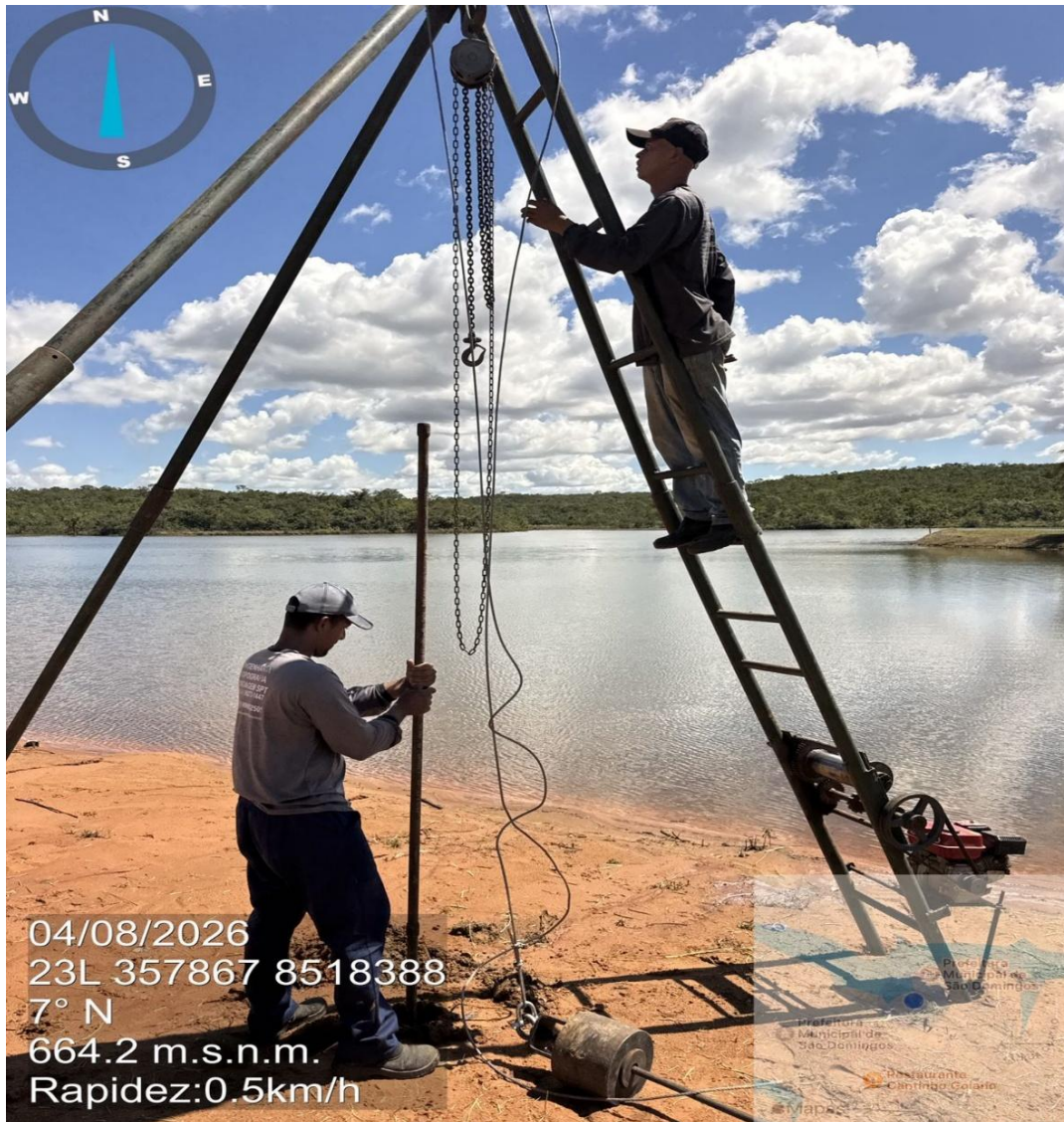
Instalação do Furo SP02
