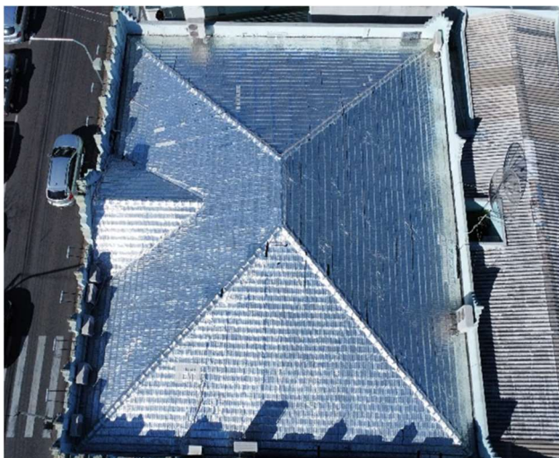
Figura 6. Imagem aérea do telhado.
