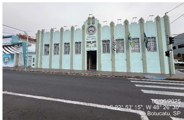
Figura 2 – Fachada do prédio
