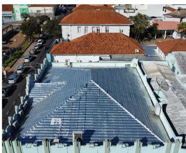
Figura 9. Imagem aérea do telhado.
