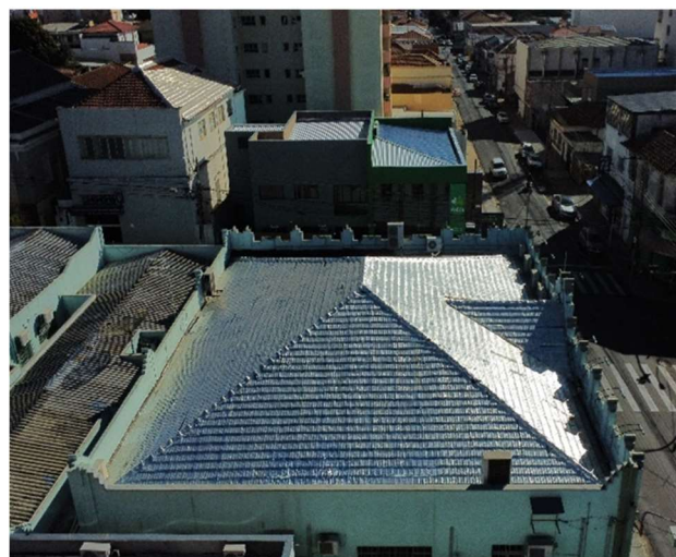
Figura 7. Imagem aérea do telhado.
