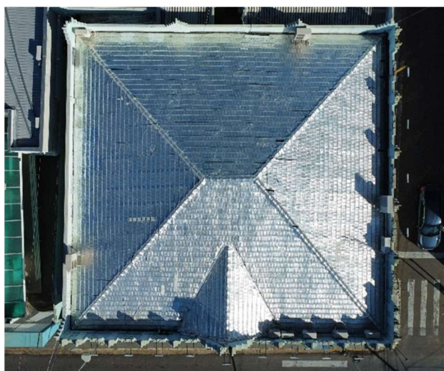
Figura 4. Imagem aérea do telhado.
