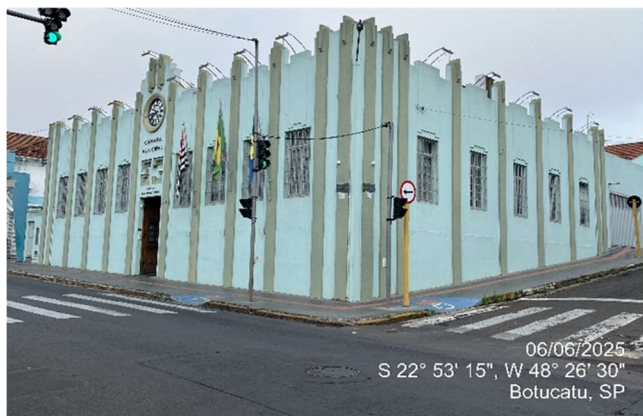
Figura 1 – Panorâmica do prédio
