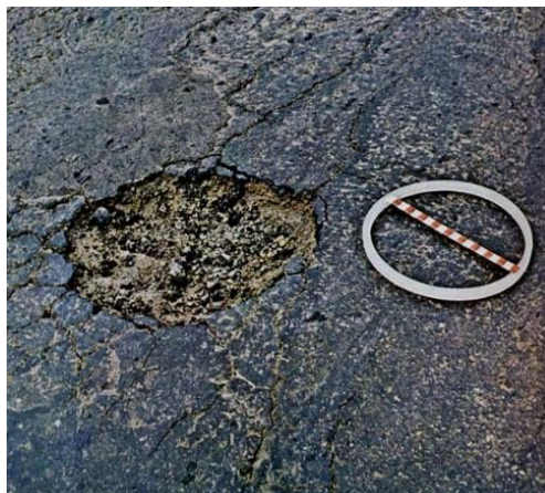
Figura 1 – Panela ou buraco. Adaptado de (DNIT, 2003).
