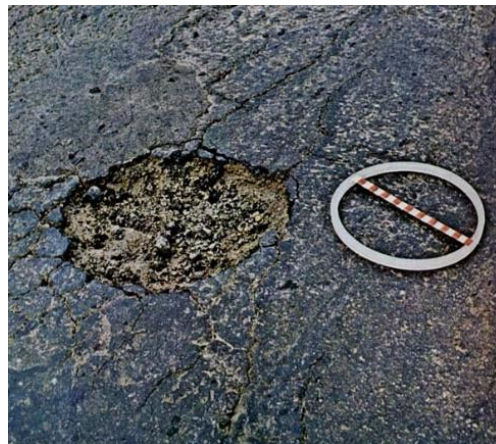
Figura 1 – Panela ou buraco. Adaptado de (DNIT, 2003).
