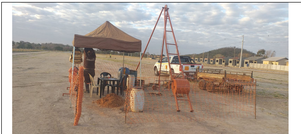
Ft.01 – Detalhe da área dos trabalhos.
