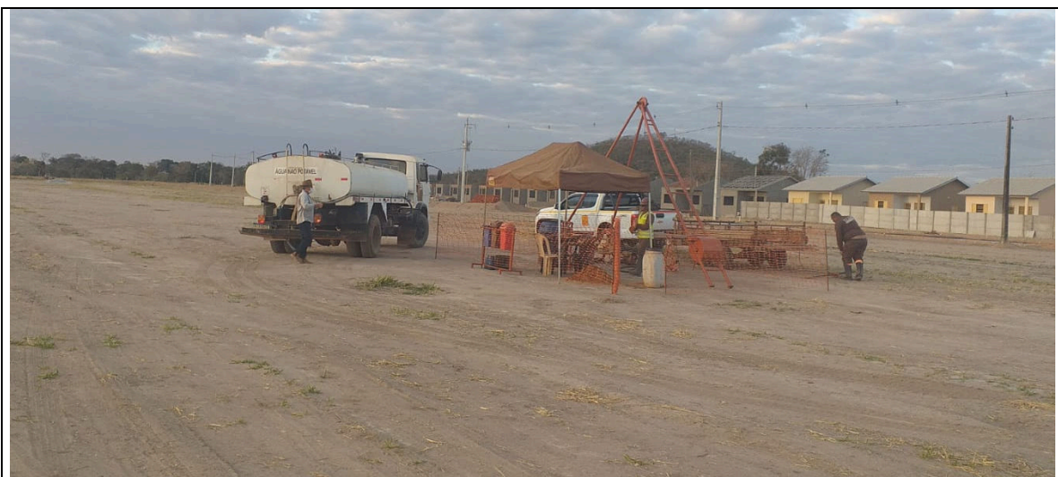
Ft.01 – Detalhe da área de trabalho.
