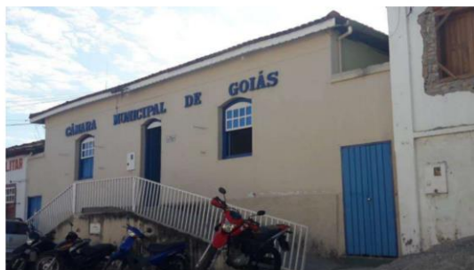
Imagem 02 - Fachada do imóvel.
