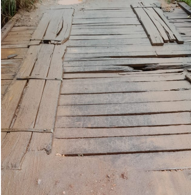
Foto 01 – Ponte de Madeira Existente
