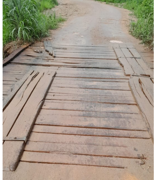
Foto 02 – Ponte de Madeira Existente
