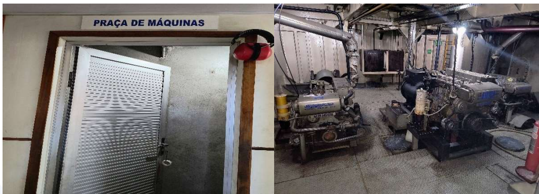
Figs. 3 Proteção em polias, isolamento de descargas, corrigir vazamento em motores.
