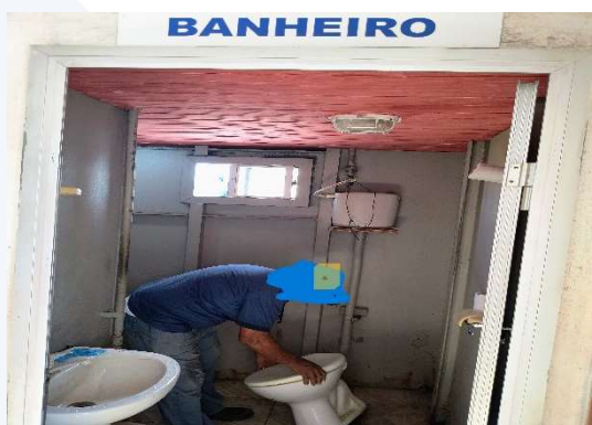
Figs.5 Camarotes com dormitórios inadequados, comando com ferrugens, banheiros com louças soltas por falta de parafusos e cozinhas com piso deteriorando.
