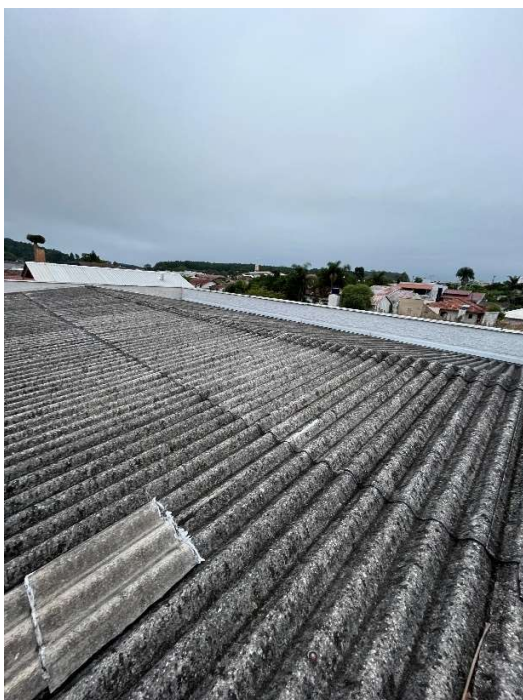
Imagens 35 e 36 – Telhas Quebradas que não foram trocadas, apenas cobertas por outros elementos - Fonte: Acervo do autor, 2024
