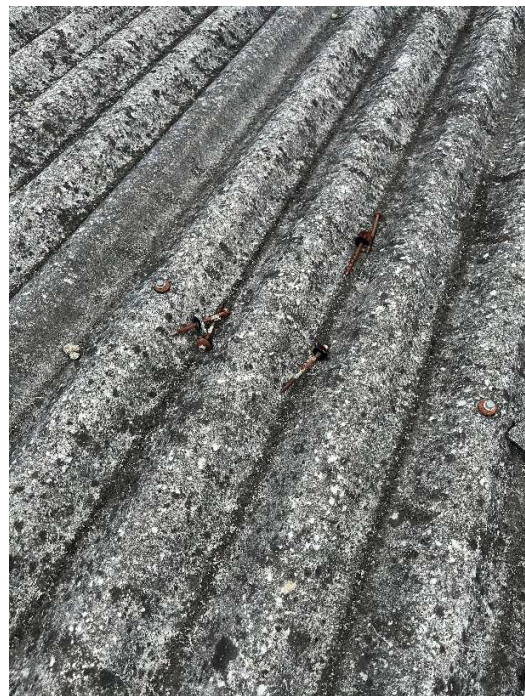
Imagens 35 e 36 – Telhas Quebradas que não foram trocadas, apenas cobertas por outros elementos - Fonte: Acervo do autor, 2024
