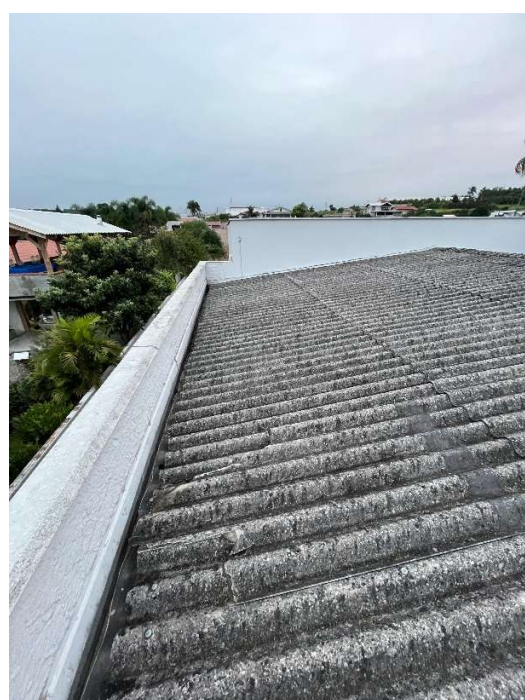
Imagens 35 e 36 – Telhas Quebradas que não foram trocadas, apenas cobertas por outros elementos - Fonte: Acervo do autor, 2024
