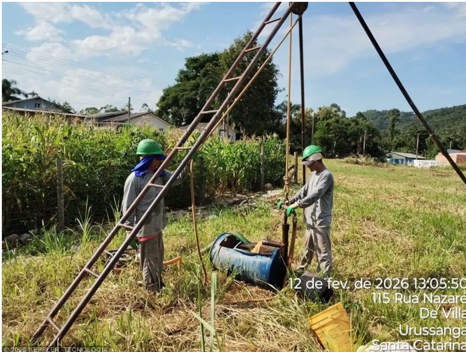
Foto 3 – SPT 11.2 - RUA NAZARÉ - URUSSANGA
