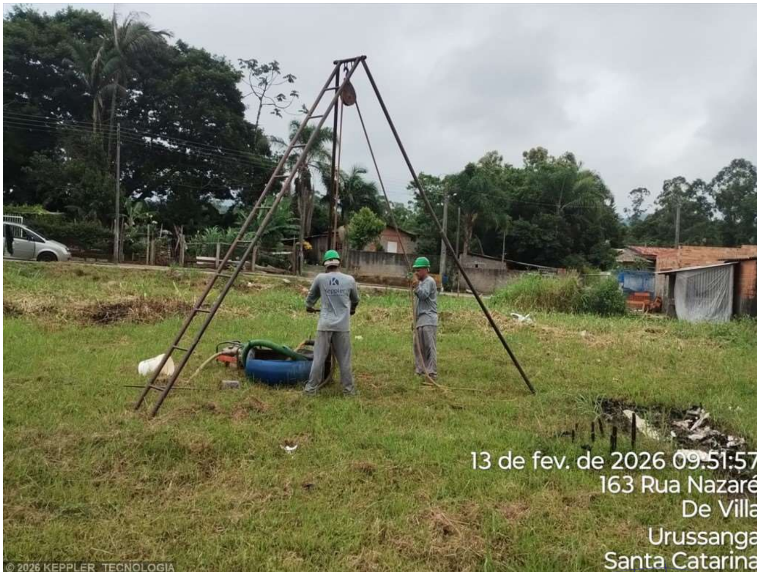
Foto 1 – SPT 15 - RUA NAZARÉ - URUSSANGA
