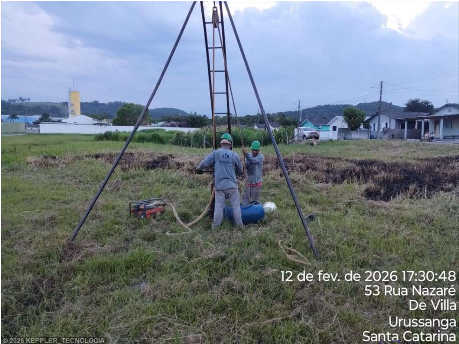
Foto 3 – SPT 14.2 - RUA NAZARÉ - URUSSANGA
