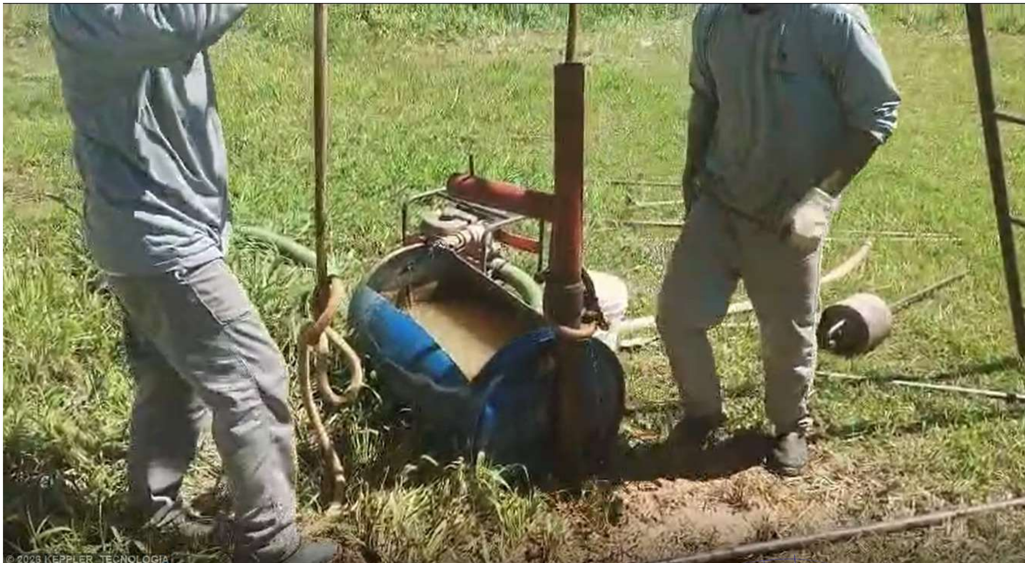
Foto 1 – SPT 1 - RUA NAZARÉ - URUSSANGA
