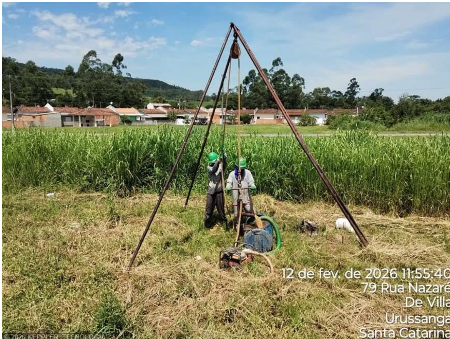
Foto 3 – SPT 10.2 - RUA NAZARÉ - URUSSANGA
