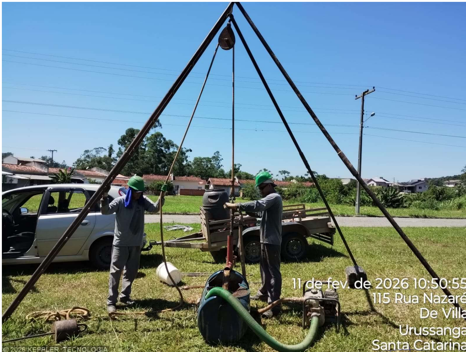
Foto 2 – SPT 4.1 - RUA NAZARÉ - URUSSANGA
