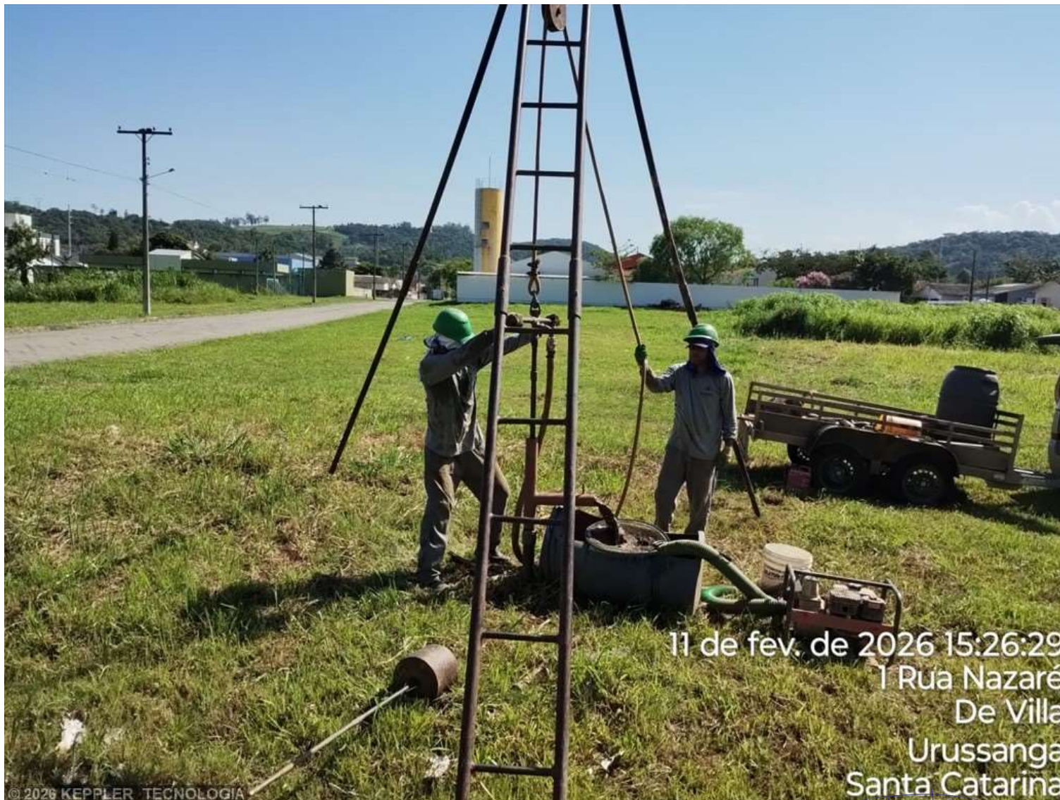
Foto 1 – SPT 6 - RUA NAZARÉ - URUSSANGA
