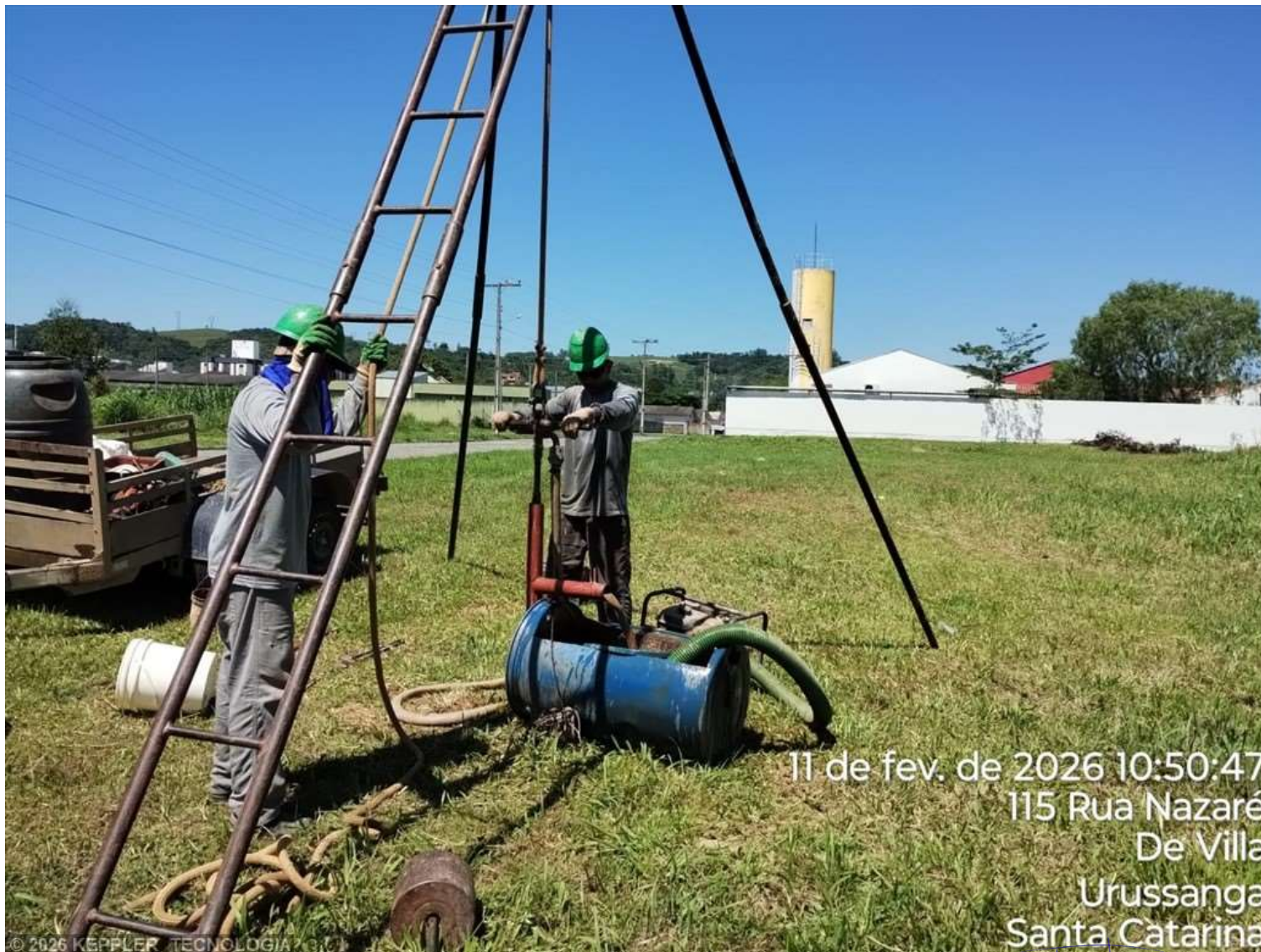
Foto 1 – SPT 4 - RUA NAZARÉ - URUSSANGA
