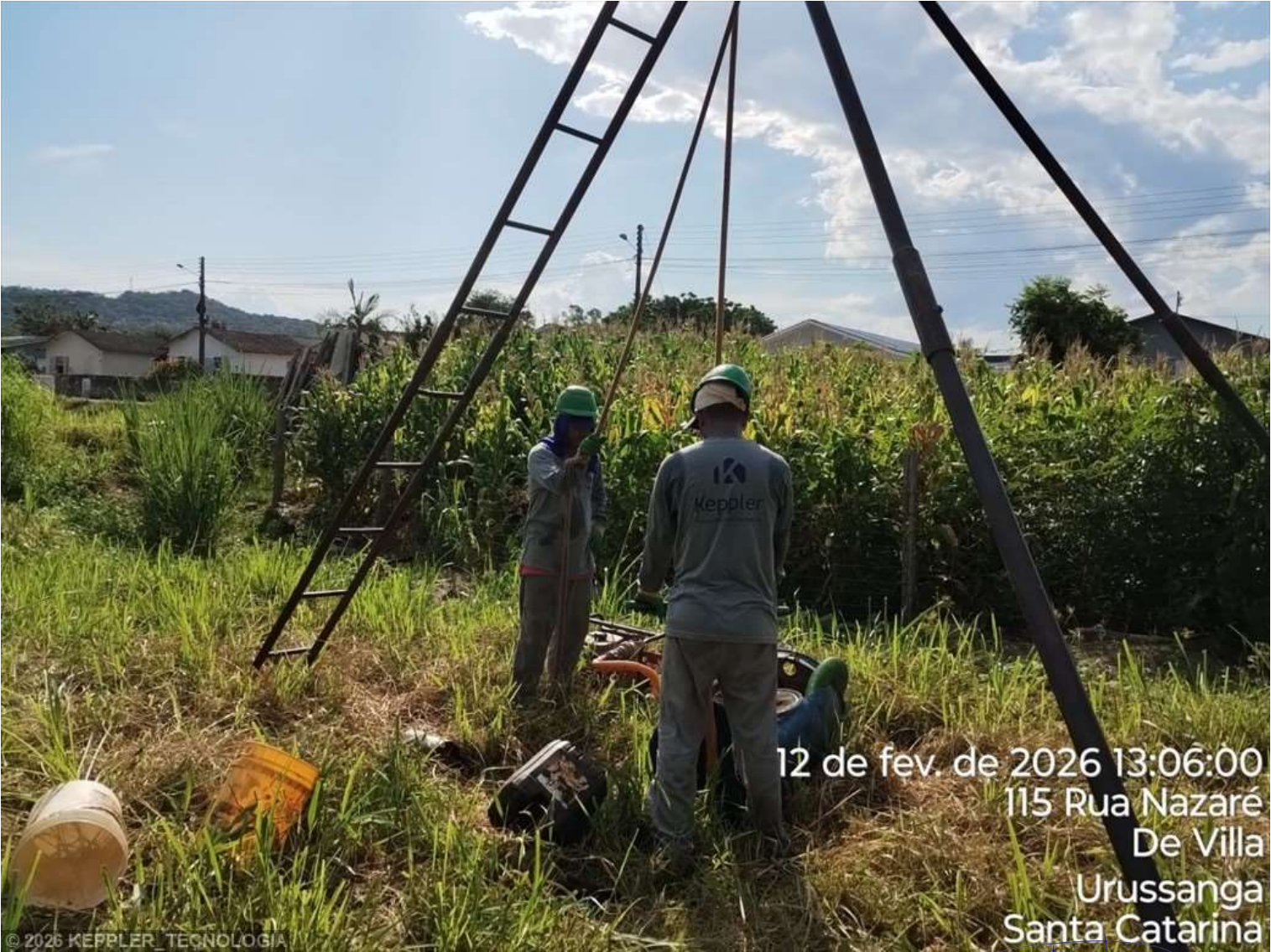
Foto 2 – SPT 11.1 - RUA NAZARÉ - URUSSANGA
