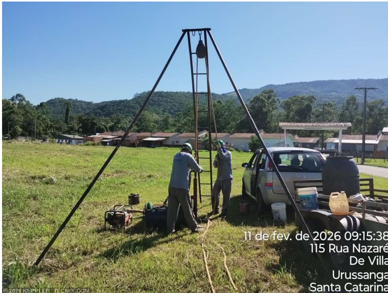
Foto 2 – SPT 3.1 - RUA NAZARÉ - URUSSANGA
