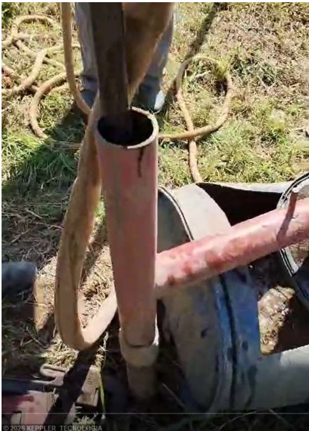
Foto 1 – SPT 7 - RUA NAZARÉ - URUSSANGA
