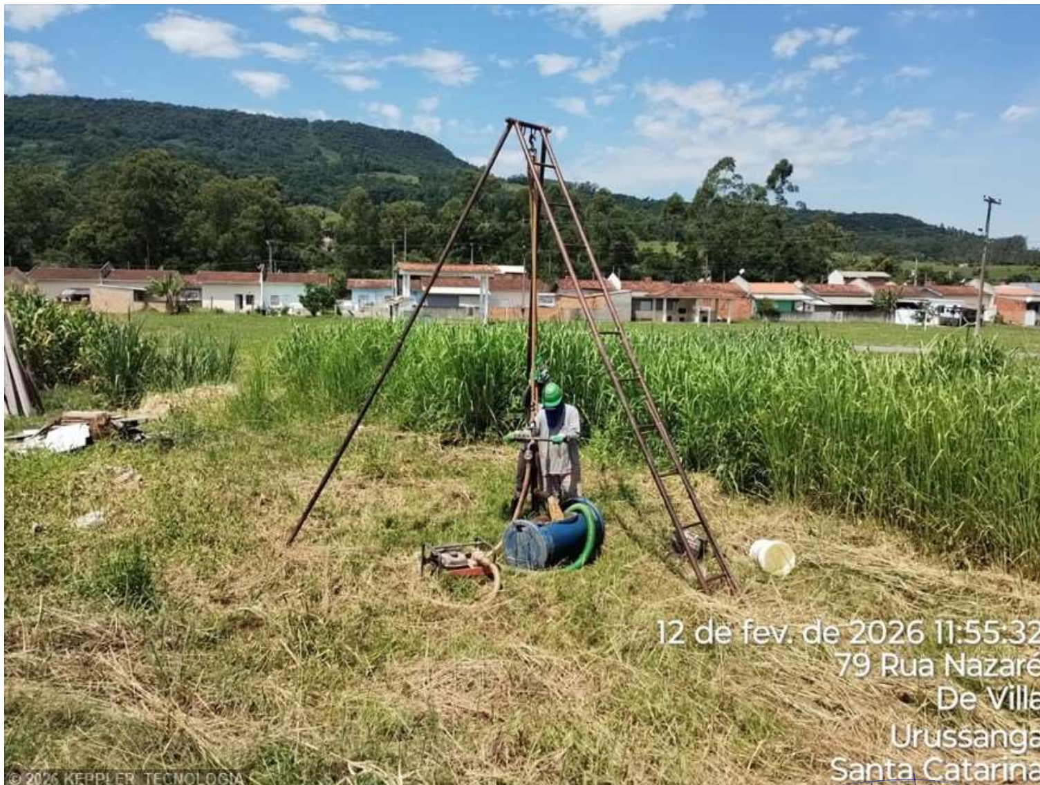
Foto 1 – SPT 10 - RUA NAZARÉ - URUSSANGA
