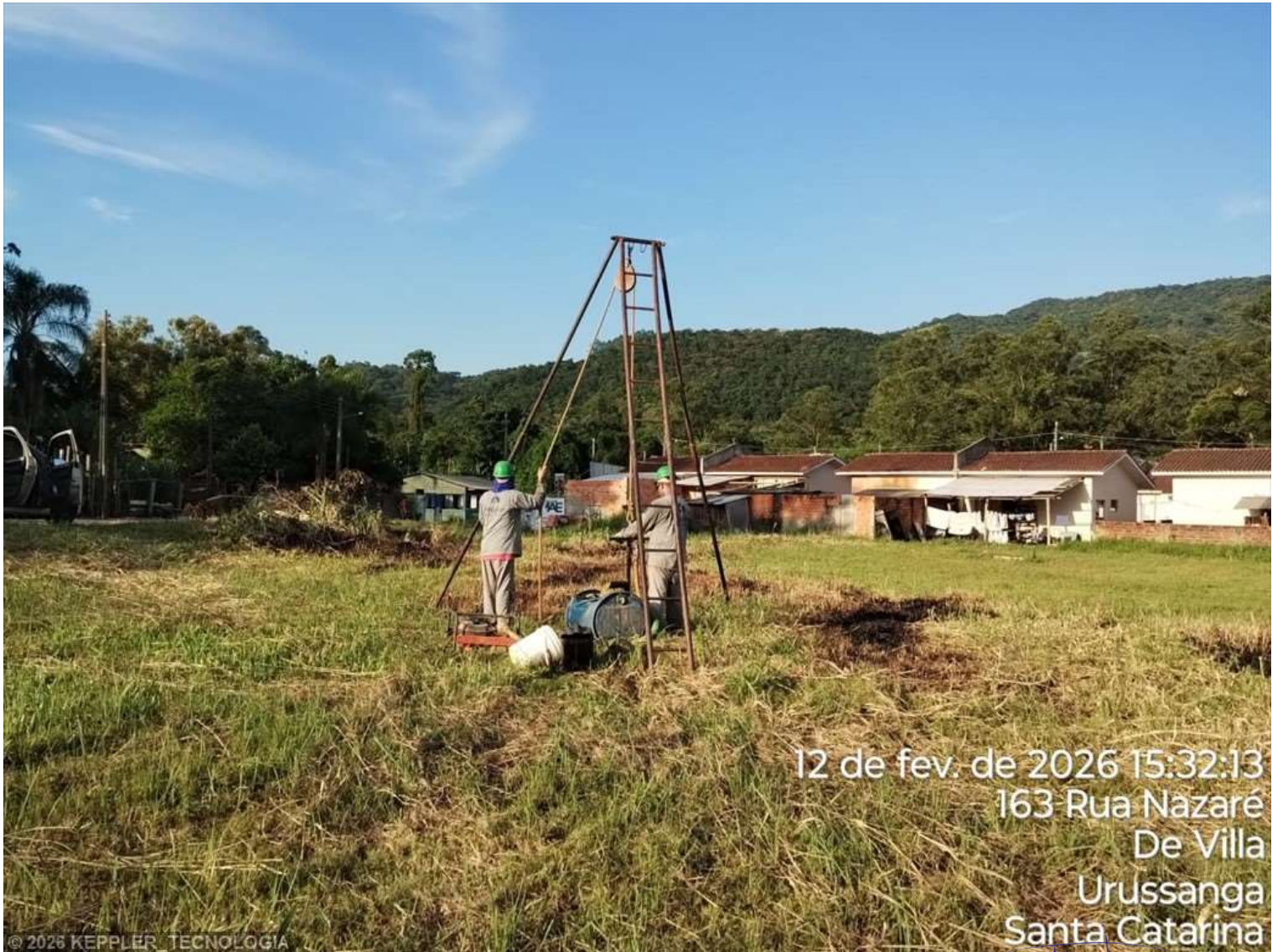
Foto 3 – SPT 13.2 - RUA NAZARÉ - URUSSANGA
