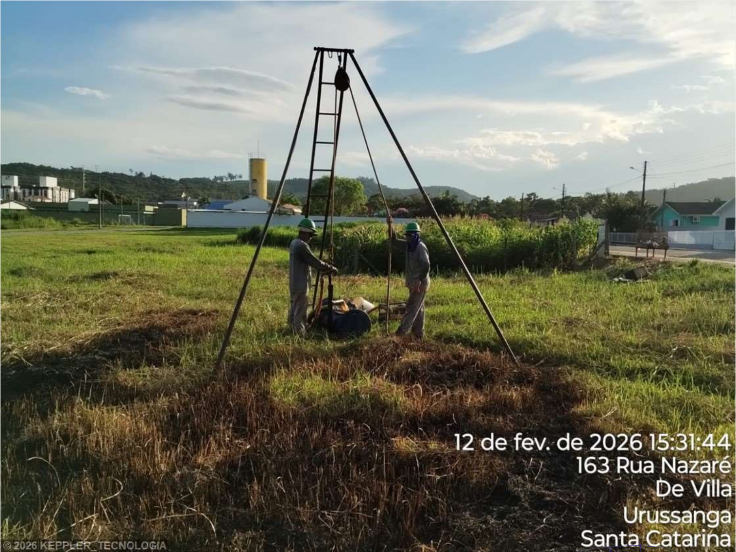
Foto 1 – SPT 13 - RUA NAZARÉ - URUSSANGA
