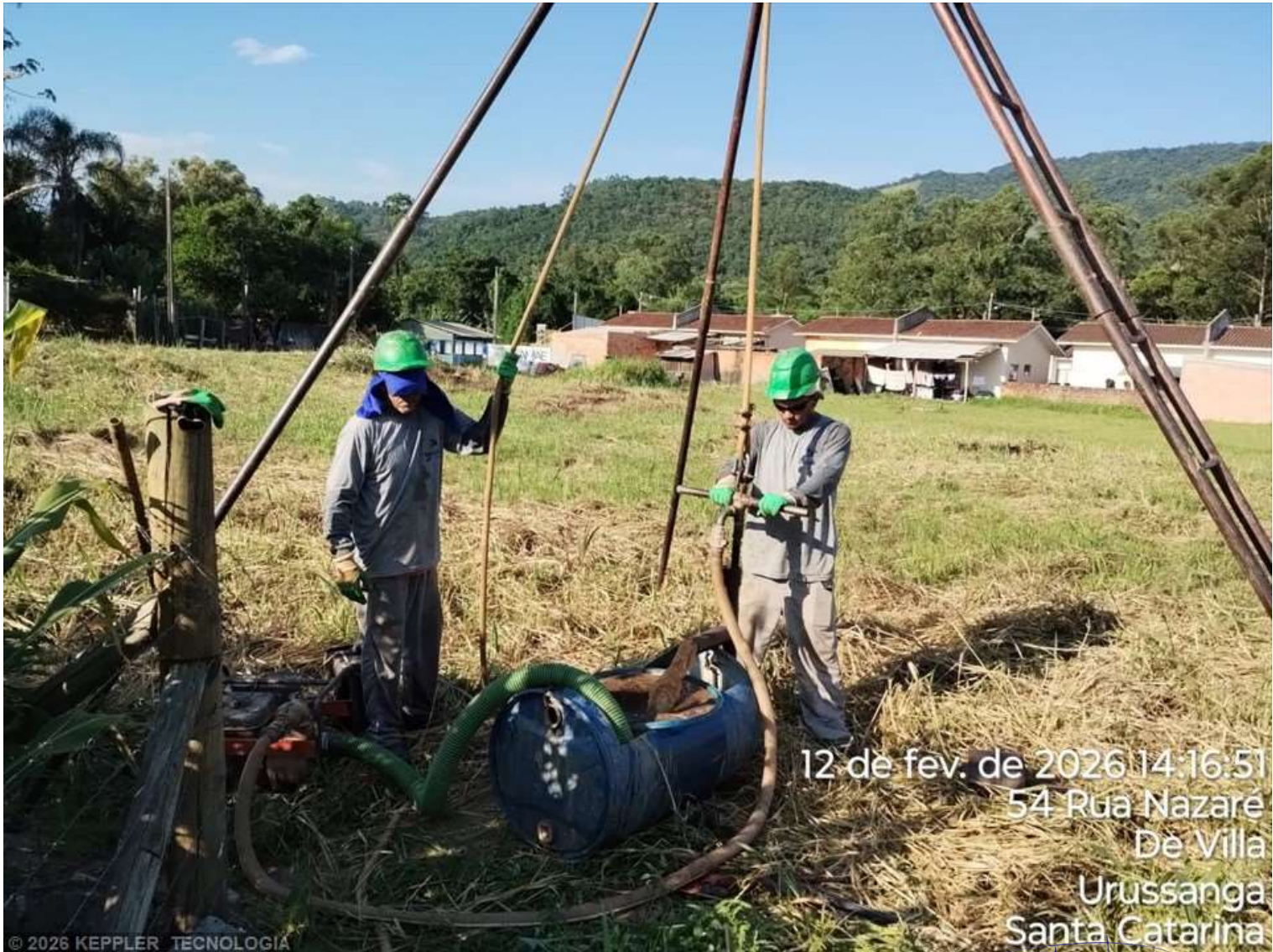
Foto 3 – SPT 12.2 - RUA NAZARÉ - URUSSANGA
