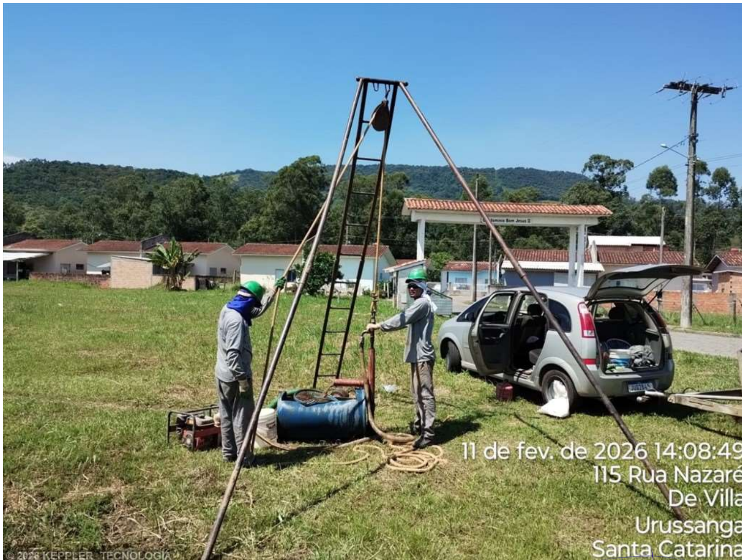
Foto 1 – SPT 5 - RUA NAZARÉ - URUSSANGA
