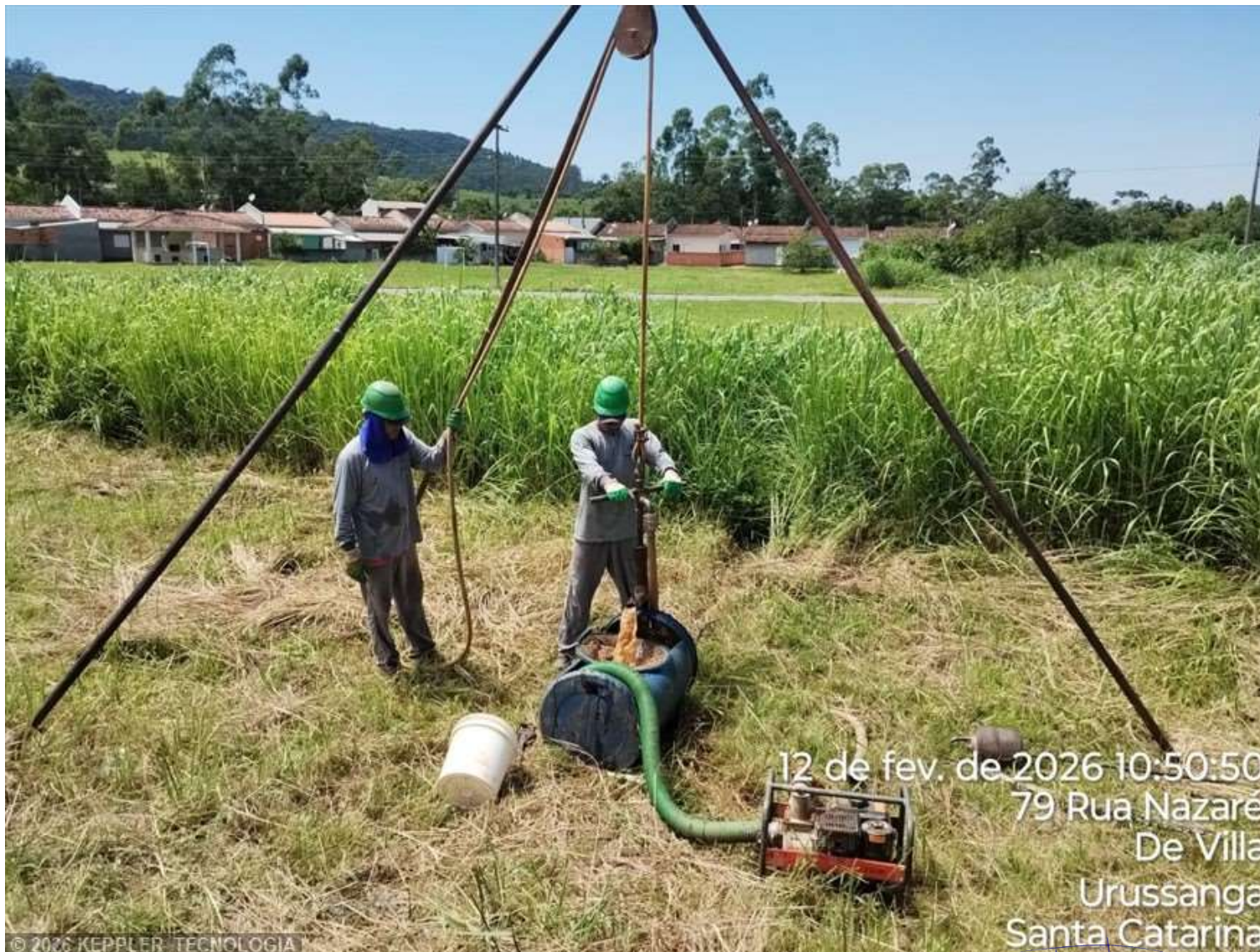
Foto 1 – SPT 9 - RUA NAZARÉ - URUSSANGA
