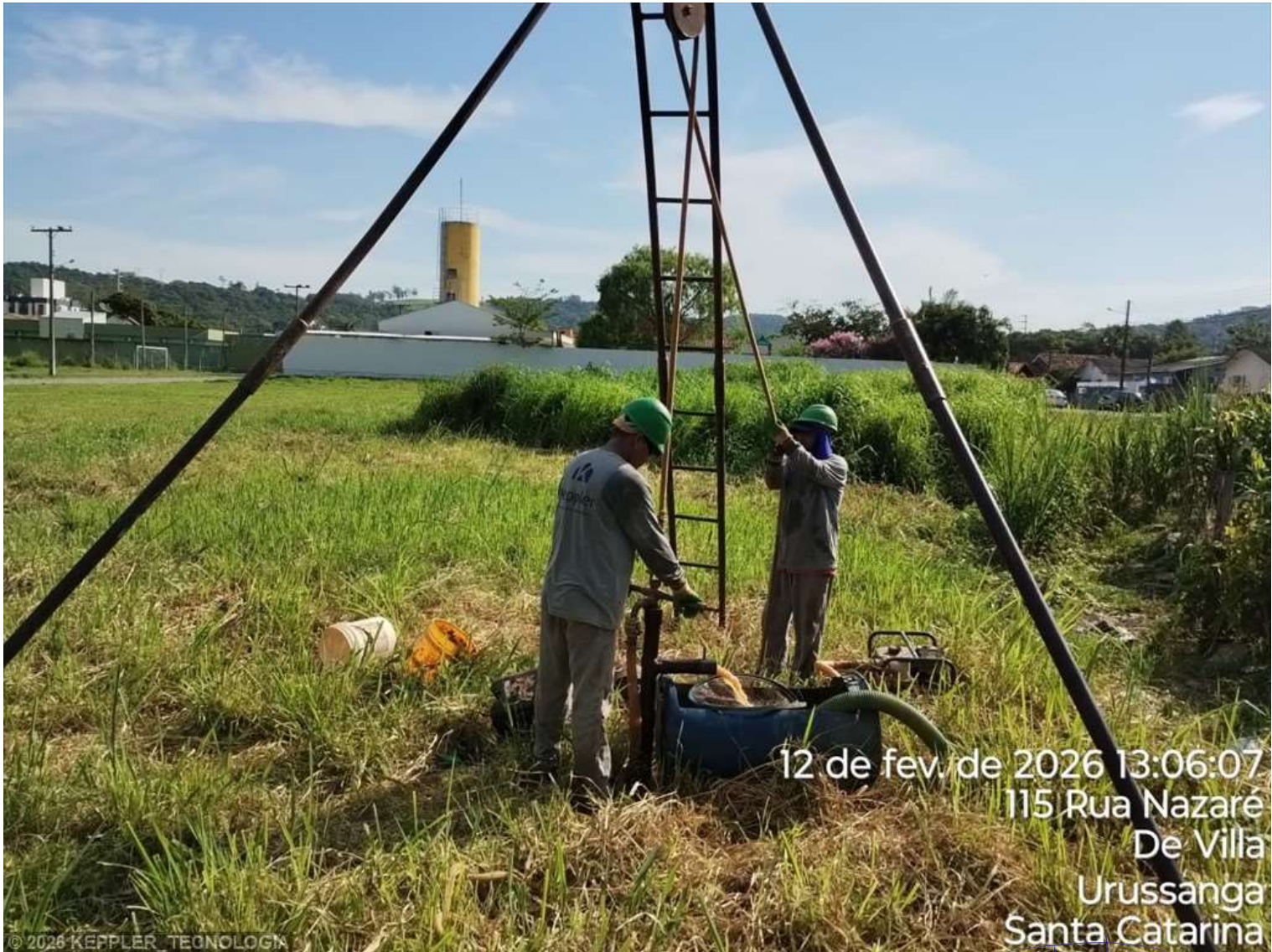
Foto 1 – SPT 11 - RUA NAZARÉ - URUSSANGA
