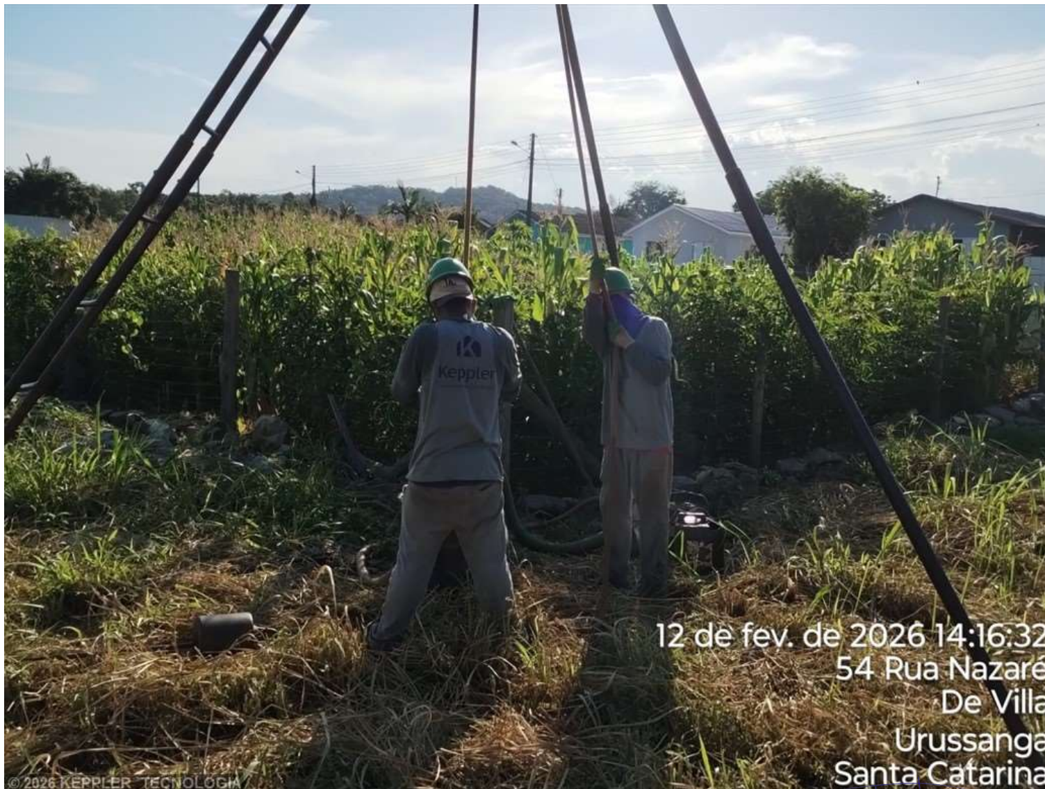
Foto 2 – SPT 12.1 - RUA NAZARÉ - URUSSANGA
