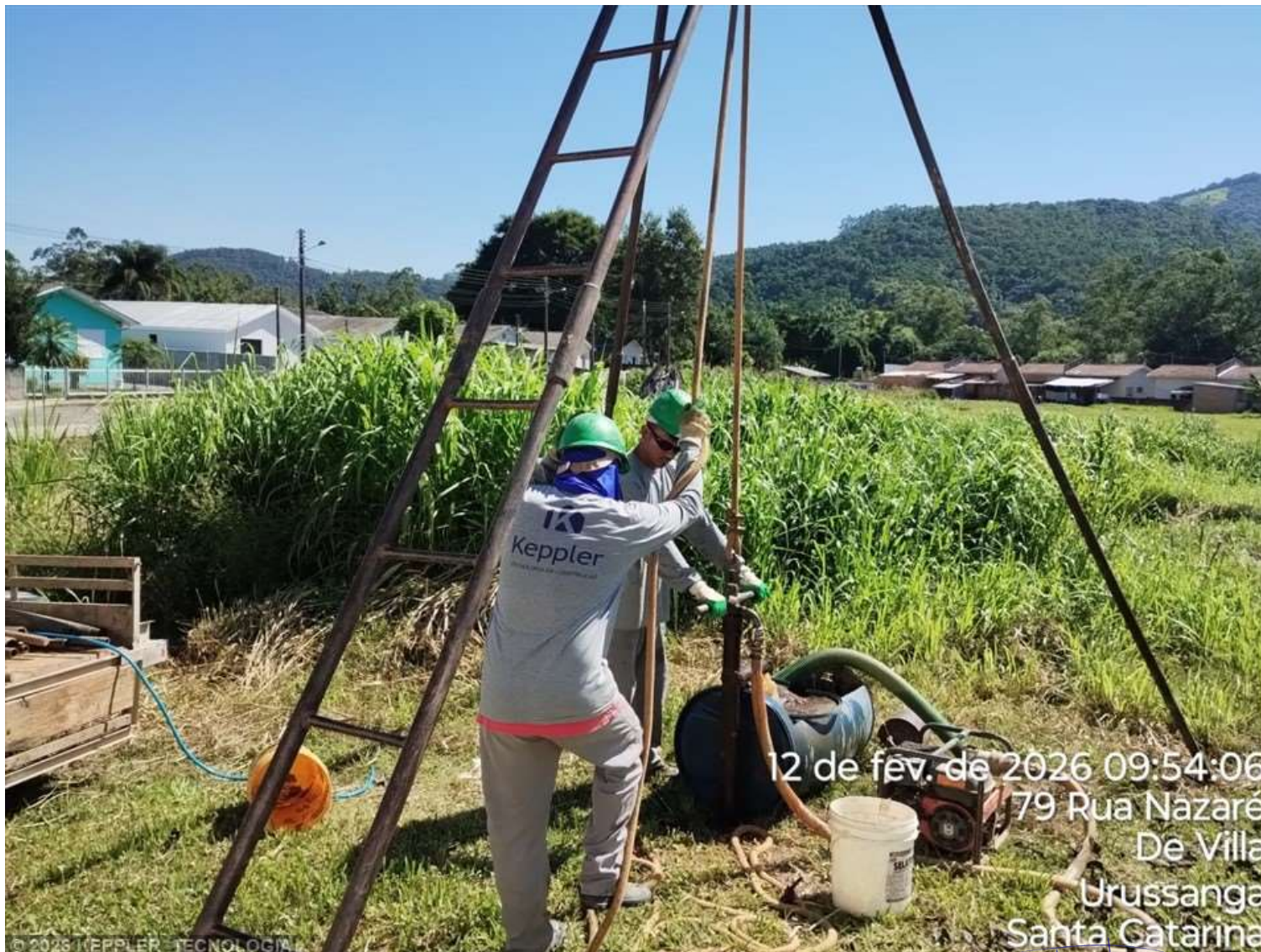
Foto 3 – SPT 8.2 - RUA NAZARÉ - URUSSANGA
