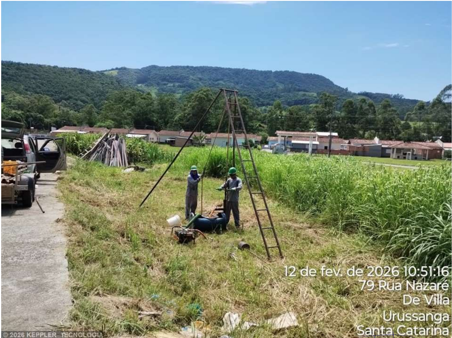
Foto 2 – SPT 9.1 - RUA NAZARÉ - URUSSANGA
