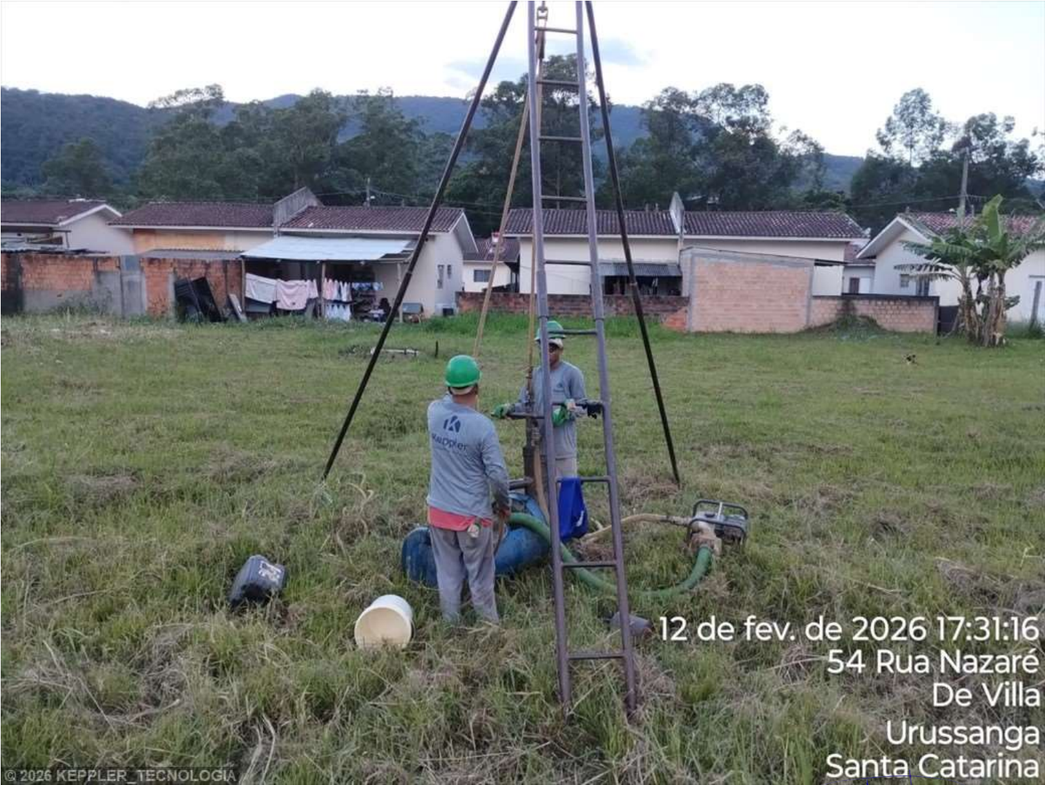
Foto 2 – SPT 14.1 - RUA NAZARÉ - URUSSANGA
