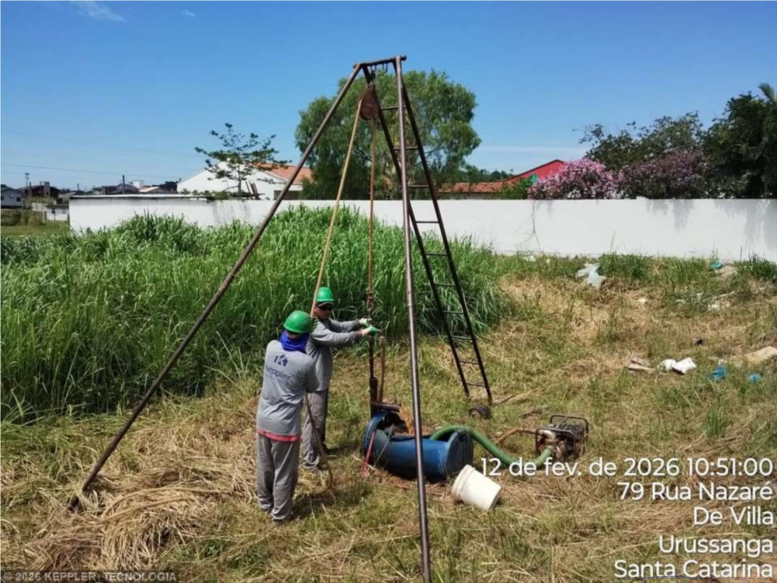
Foto 3 – SPT 9.2 - RUA NAZARÉ - URUSSANGA
