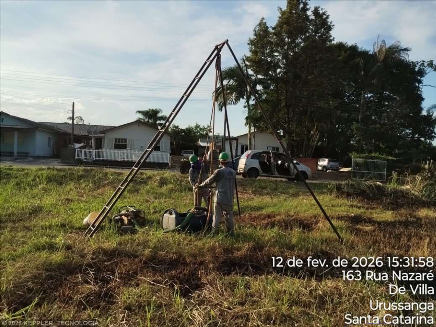
Foto 2 – SPT 13.1 - RUA NAZARÉ - URUSSANGA
