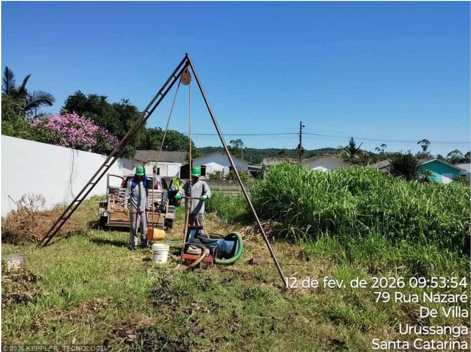
Foto 2 – SPT 8.1 - RUA NAZARÉ - URUSSANGA
