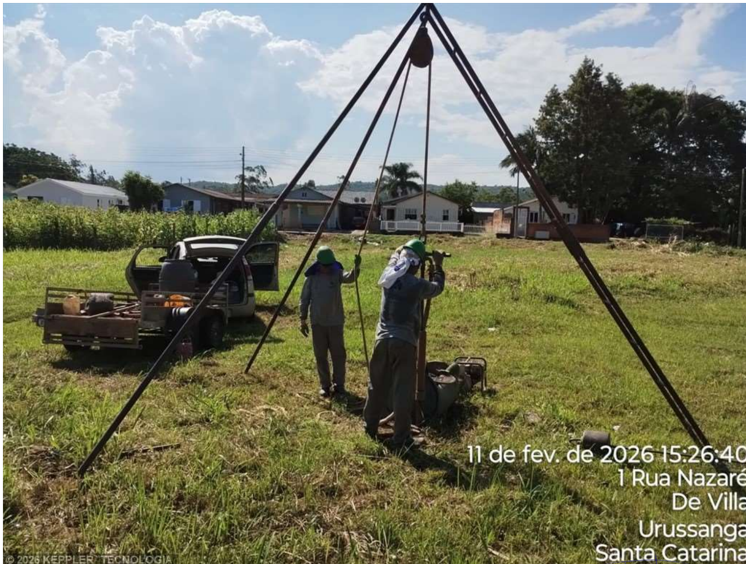
Foto 2 – SPT 6.1 - RUA NAZARÉ - URUSSANGA
