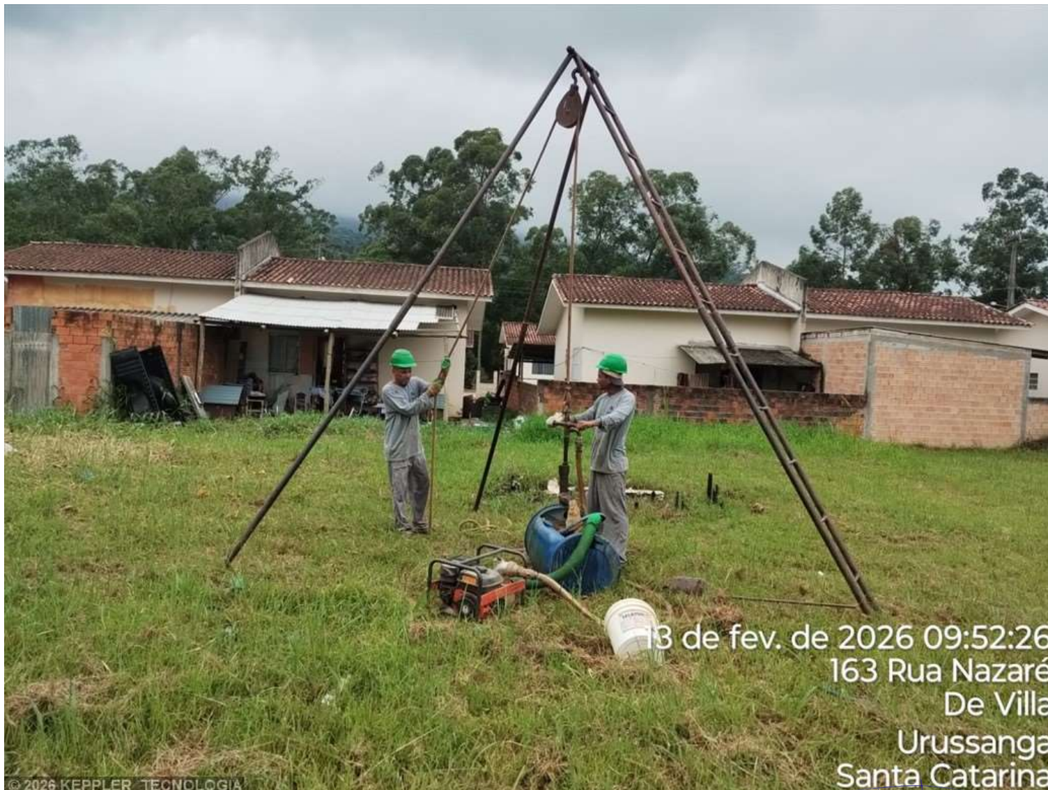
Foto 2 – SPT 15.1 - RUA NAZARÉ - URUSSANGA
