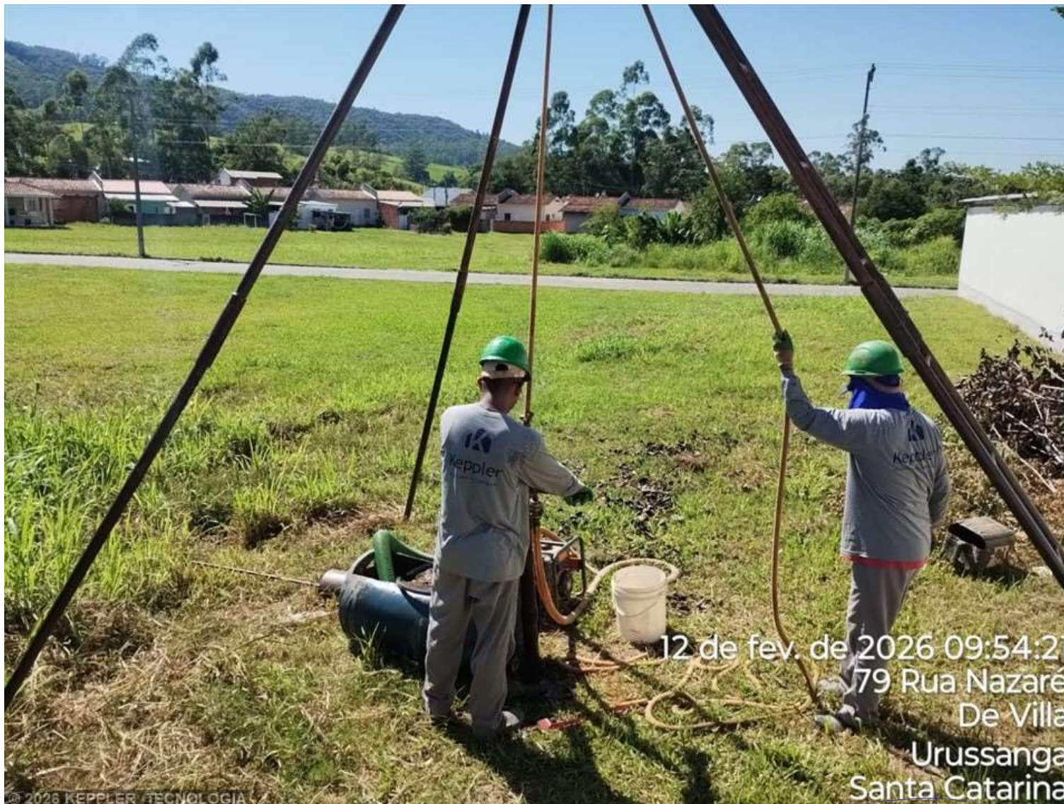
Foto 1 – SPT 8 - RUA NAZARÉ - URUSSANGA
