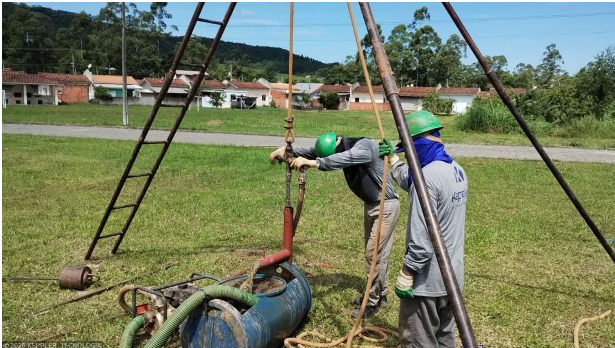
Foto 1 – SPT 2 - RUA NAZARÉ - URUSSANGA
