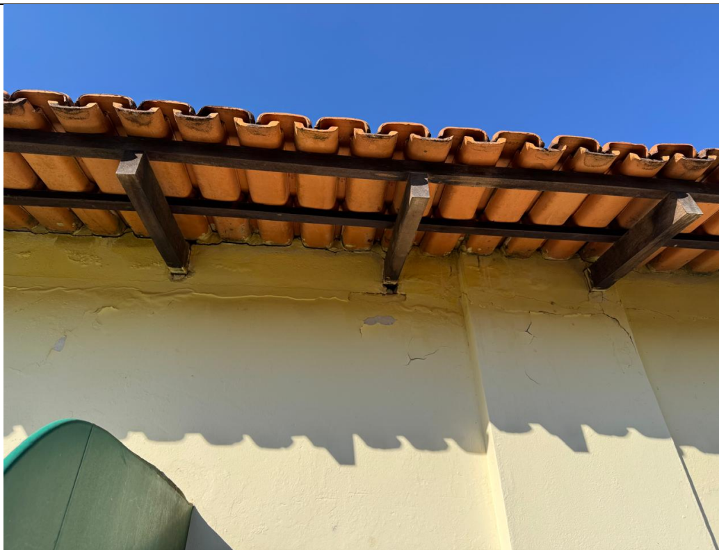
Detalhe da viga que irá receber nova estrutura de ampliação
