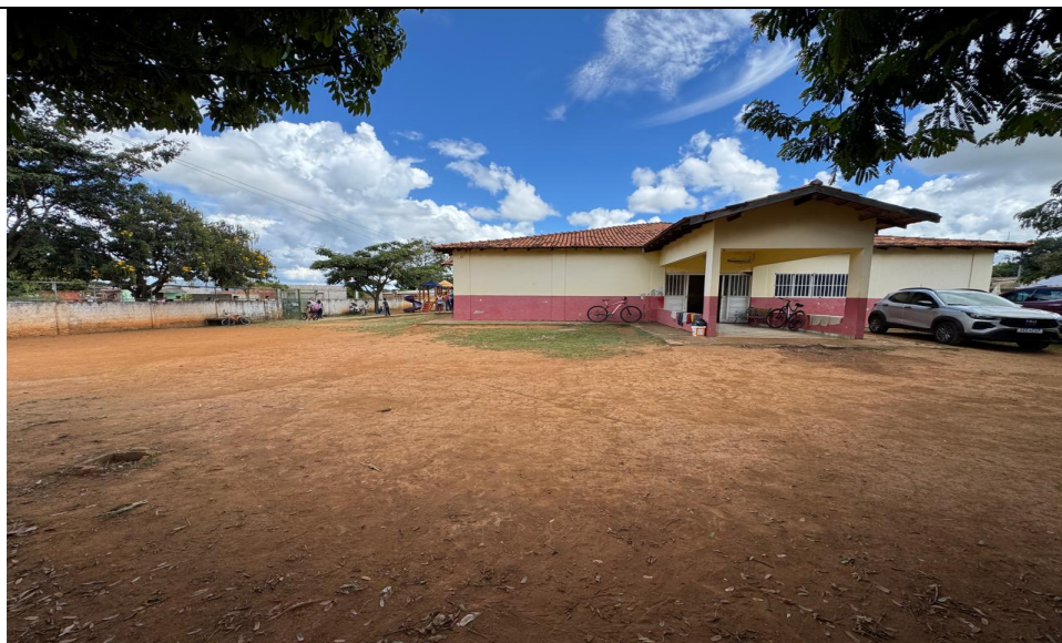
Fachada Lateral, onde será construída as duas novas salas
