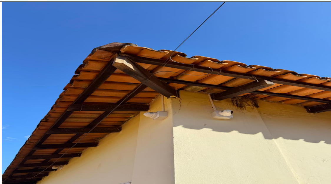
Detalhe do pilar que irá receber nova estrutura de ampliação
