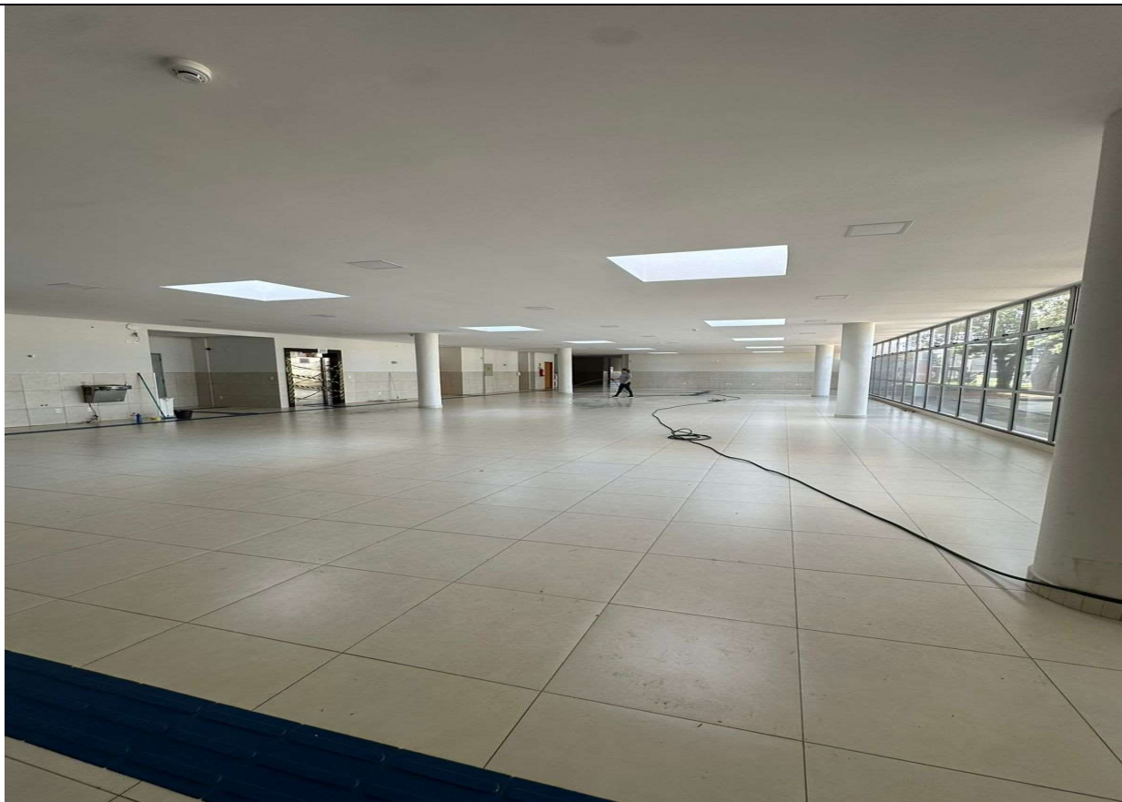
FOTO 06 – ESPAÇO ONDE SERÁ REALIZADA DIVISÓRIAS PARA SALAS DE AUDITÓRIO, CADASTRO E COLETORIA.
