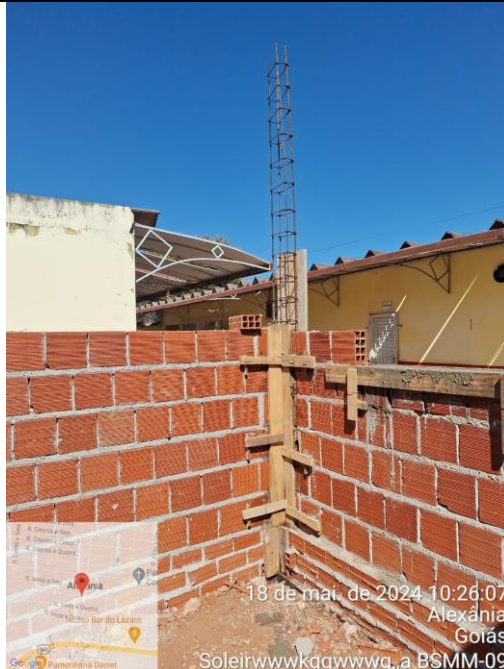
Pilares com caixaria fechada
