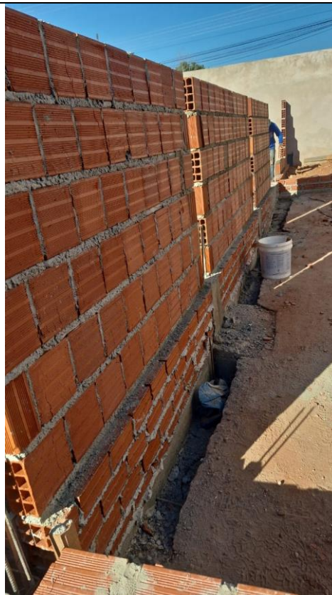
Base terminada e alvenaria iniciada
