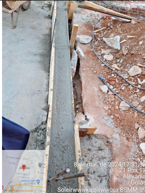
Concretagem vigas baldrame
