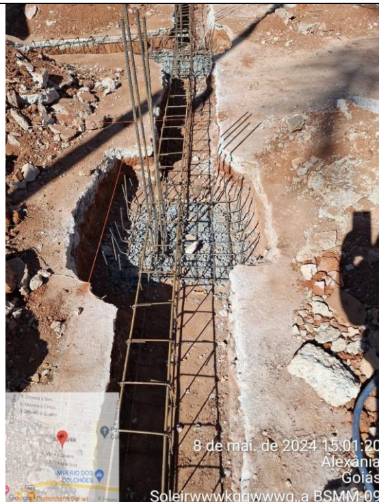
Ferragens vigas baldrames e sapatas
