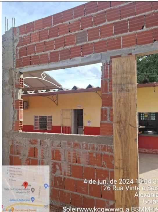
Alvenaria sendo executada
