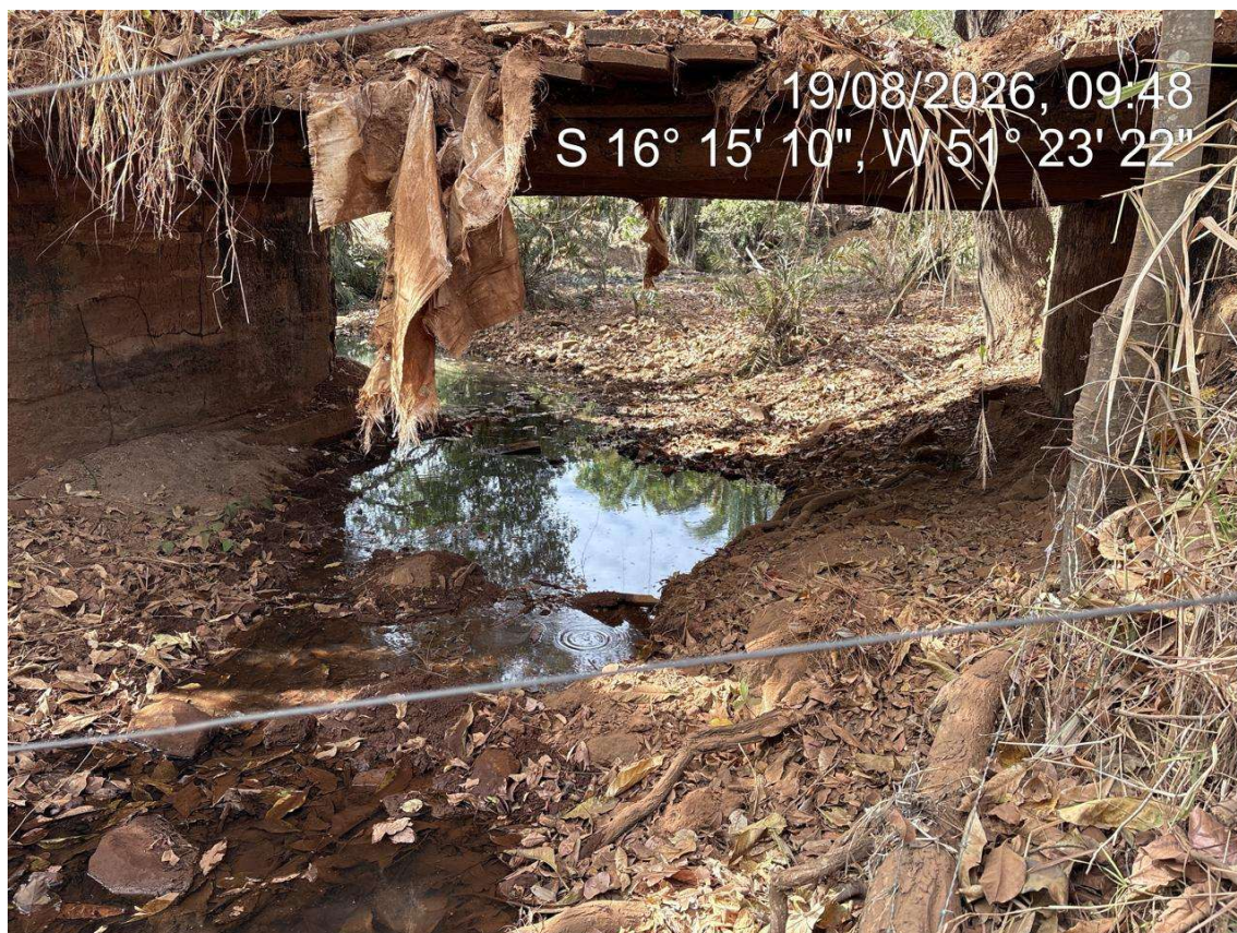
Imagem: Construção de Bueiro, região do Serra Verde, Propriedade do Sr JOSÉ LEMES SIQUEIRA (ANTES)
