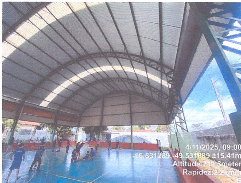
Figura 1. Situação Atual – Área interna.
