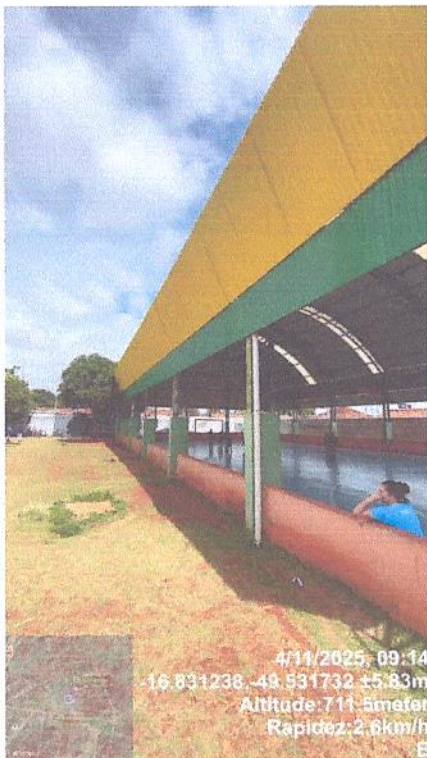
Figura 5. Situação interna da quadra, pintura desgastada e bastante fissuração.
