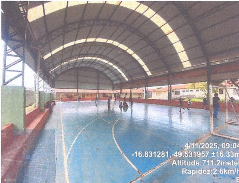
Figura 5. Situação interna da quadra, pintura desgastada e bastante fissuração.
