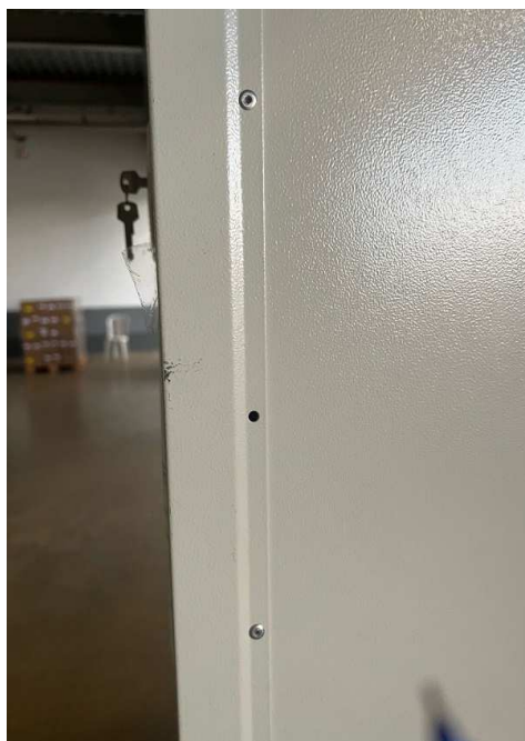
Imagem 03 – Vista lateral do protótipo com pintura com avaria que deverá ser corrigida;
