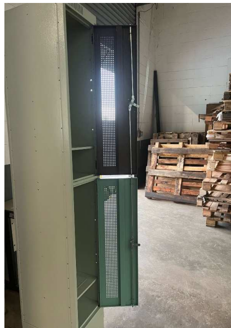
Imagem 04 – Vista interior das portas mostrando avaria da fechadura que deverá ser corrigida;
