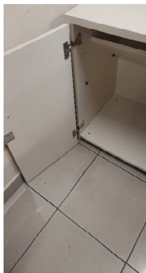
Imagem 04 – Vista interna do protótipo com prateleira regulável (divergência do distanciamento dos furos)
