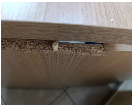
Imagem 5 – Falta de acabamento na extremidade.
