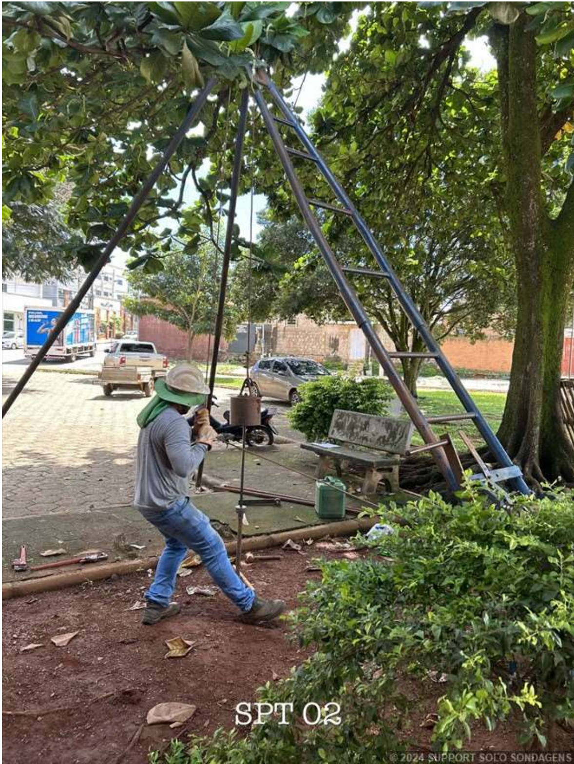
Imagem 2 – Execução de Sondagem 02
