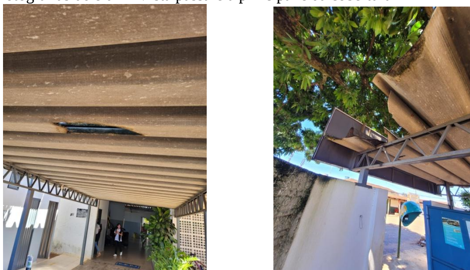
Fotografias 06 e 07 – Vista passarela principal e da cobertura
