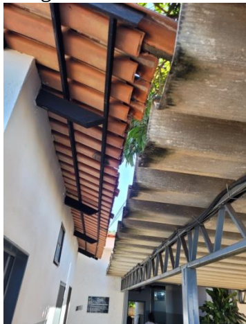
Fotografias 08 e 09 – Vista das proximidades dos telhados dos blocos sem o uso de calhas;
