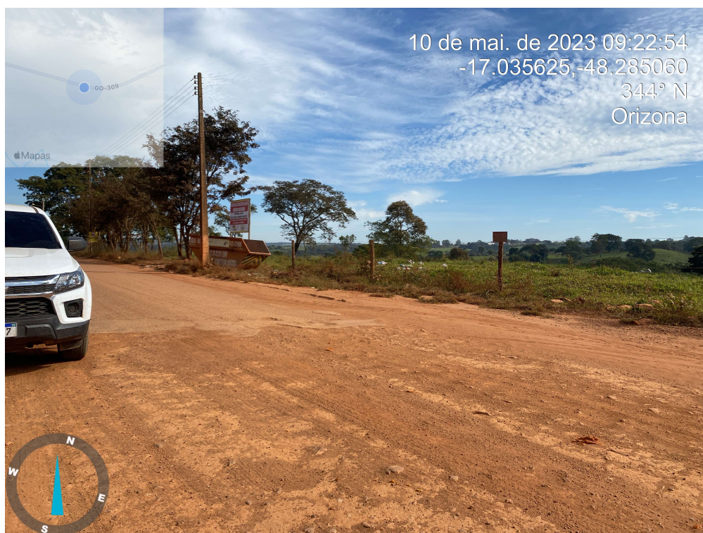
Início do Trecho – Km 0,00.
