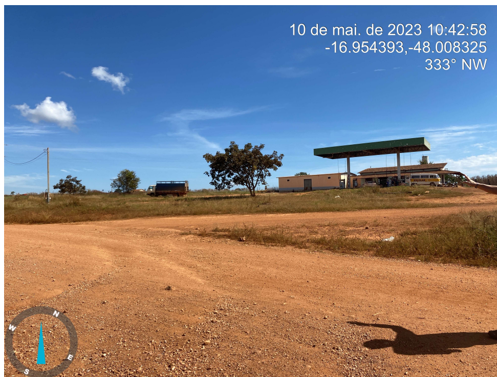
Final do trecho – Km 38,00.
