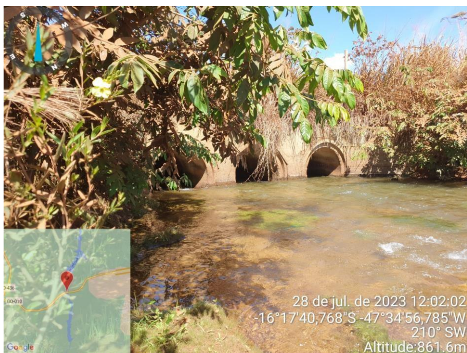
Bacia 3 - Bueiro Tubular Triplo: 5,7 Km. (SRE 010EGO0260).
