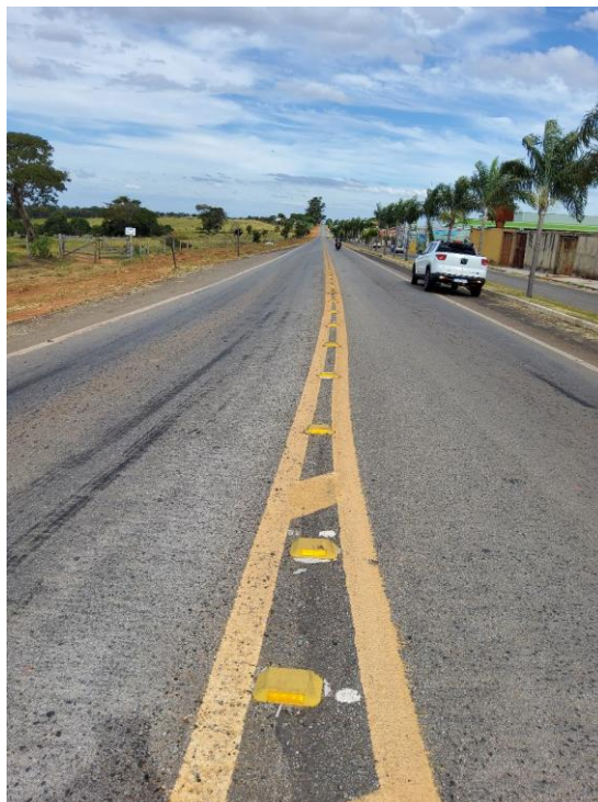
Foto 4 – km 1.1 – Rotatória para bairro.
