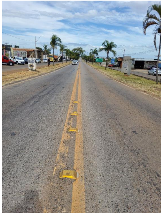
Foto 2 – km 0.1 - Início do trecho Entr. BR-050.
