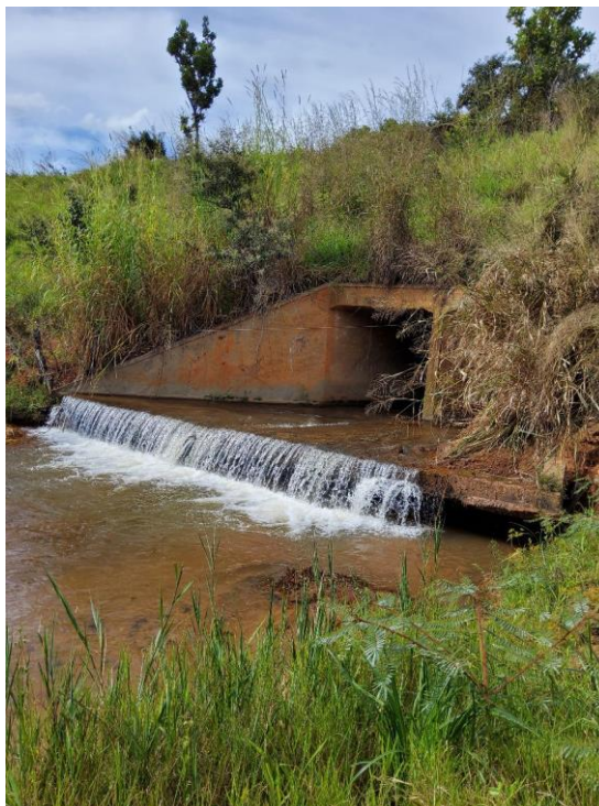
Foto 14 – km 15.6 – Bueiro celular.
