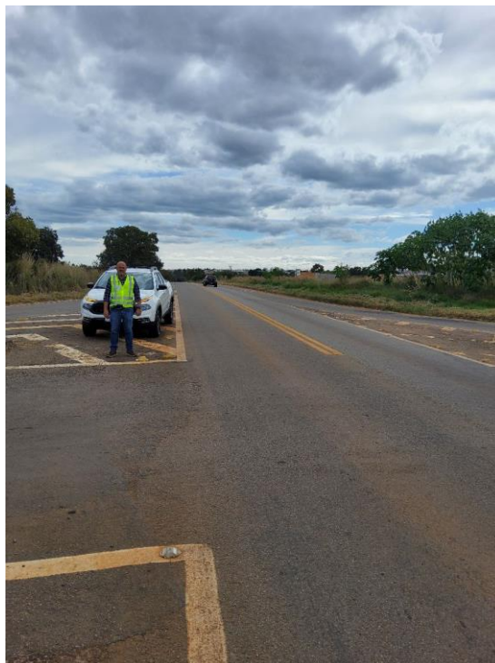
Foto 6 – km 3.6 – Rotatória para bairro.
