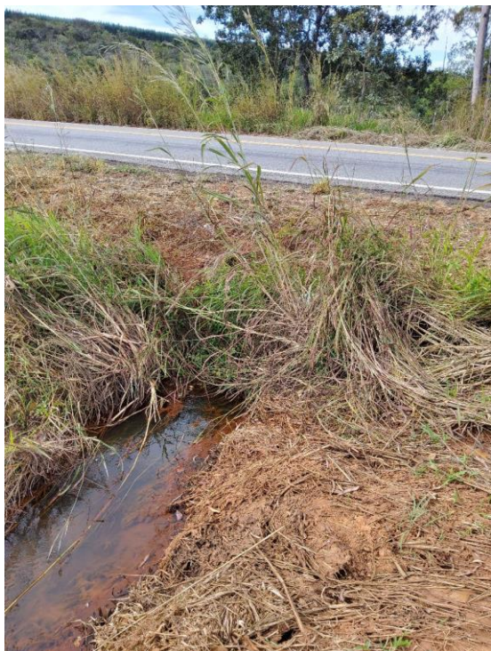
Foto 13 – km 15.8 – Bueiro tubular.
