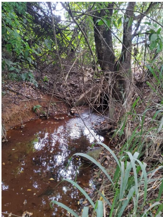
Foto 7 – km 5.4 – Bueiro tubular.
