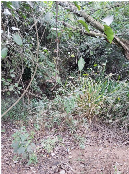
Foto 8 – km 5.5 – Vista bueiro.
