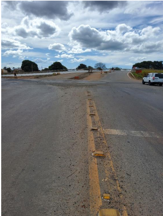
Foto 1 – km 0.1 - Início do trecho Entr. BR-050.
