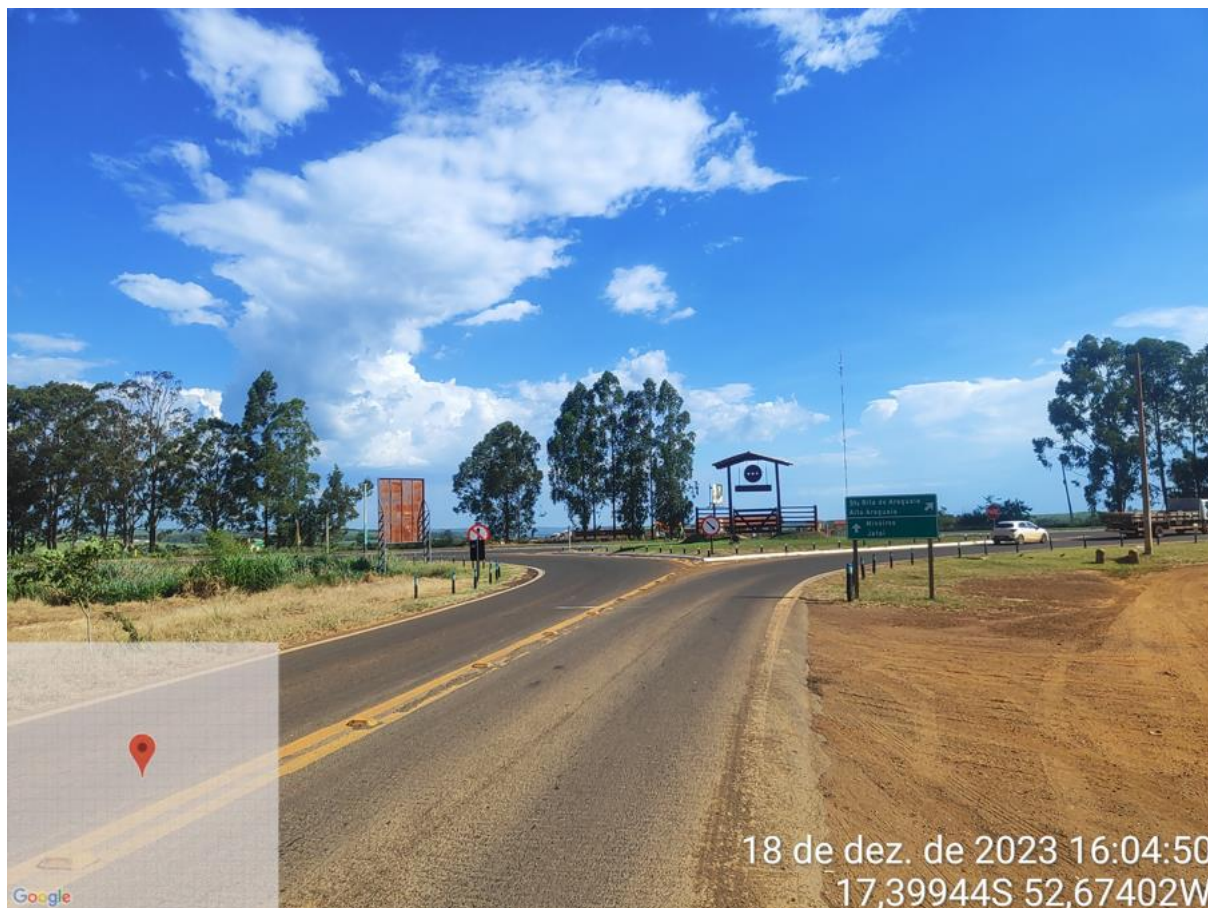
Km 0,0 – Início - GO-194, Trecho: Entrada de Portelândia/Entr. Br-364.
