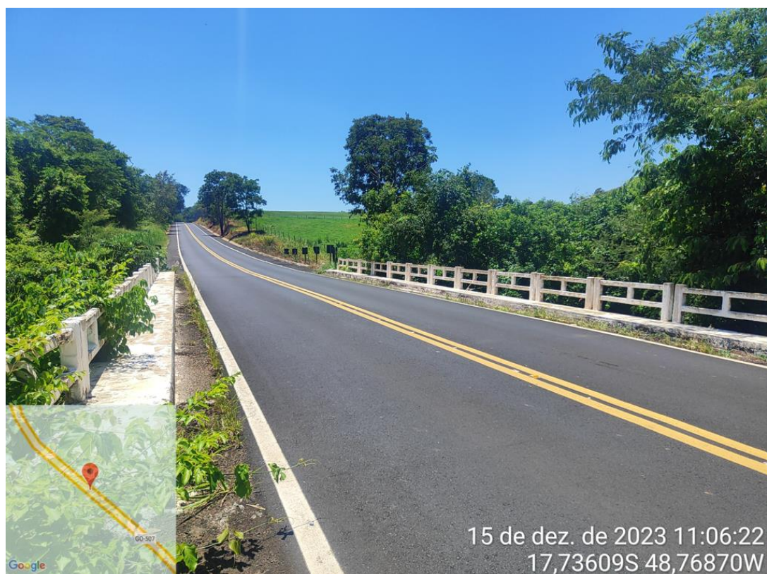
Km 10,00 – Ponte em Concreto Armado – 27,00 x 8,10m.
