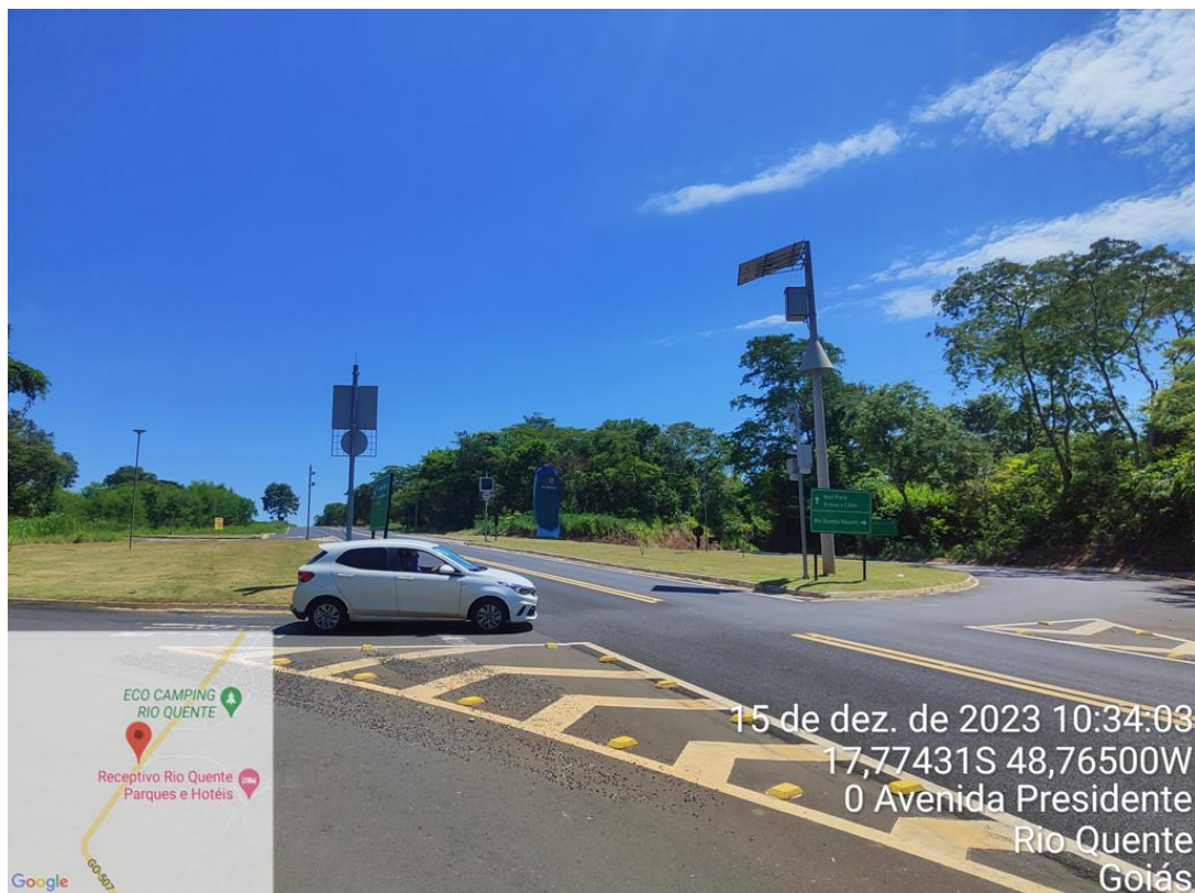
Km 4,40 – Acesso /Rio Quente.
