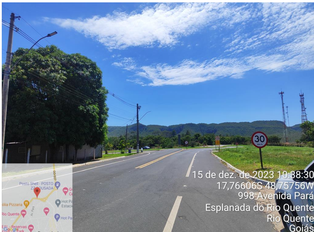
Km 5,60 - Desapropriação – Pousada do Rio Quente.
