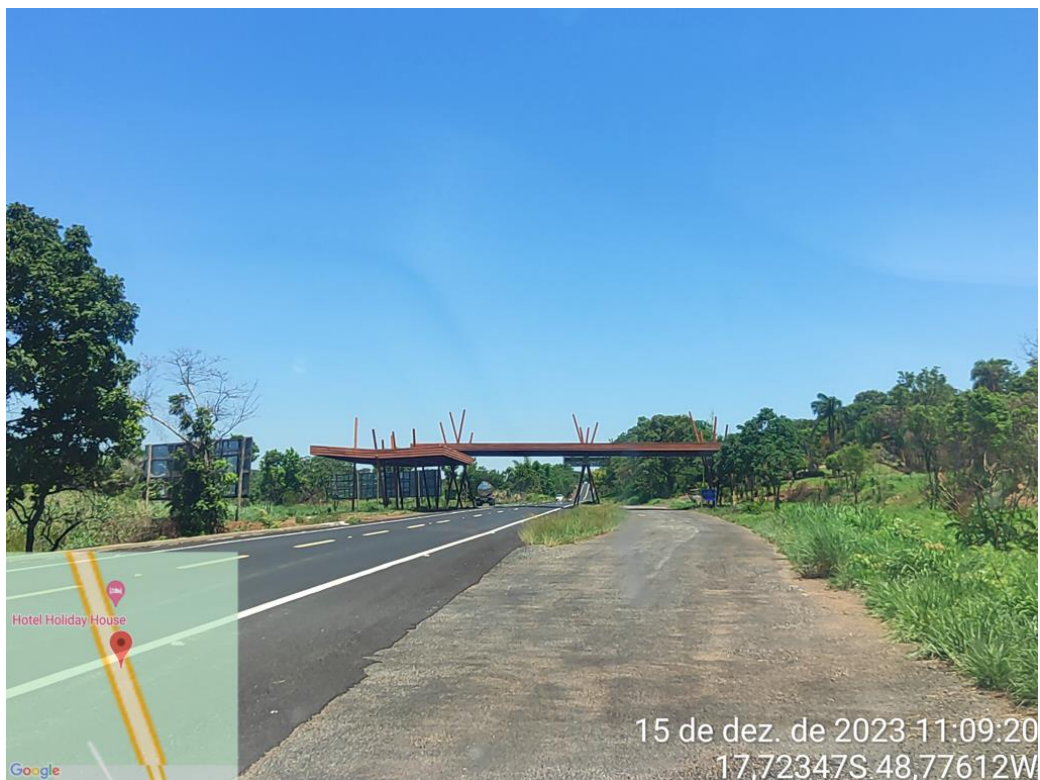
Km 11,60 – Estrutura metálica.
