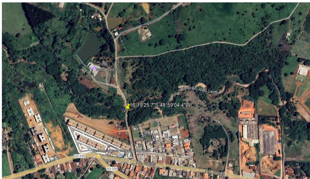
Figura 1 – Ponte sobre o Ribeirão João Leite
