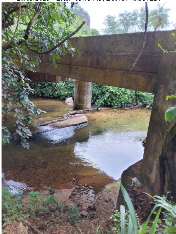
Foto 3 – Início do trecho (PCA) – km 0,0.
