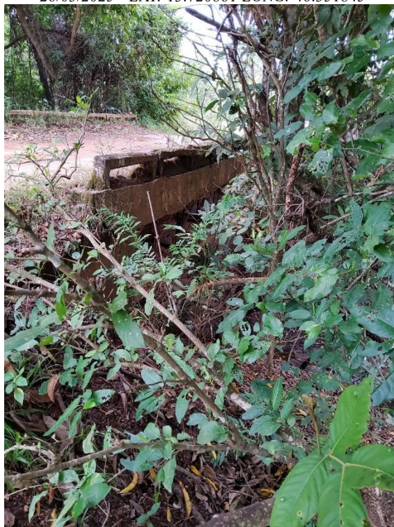
Foto 6 – Ponte Mista – km 1,7.
