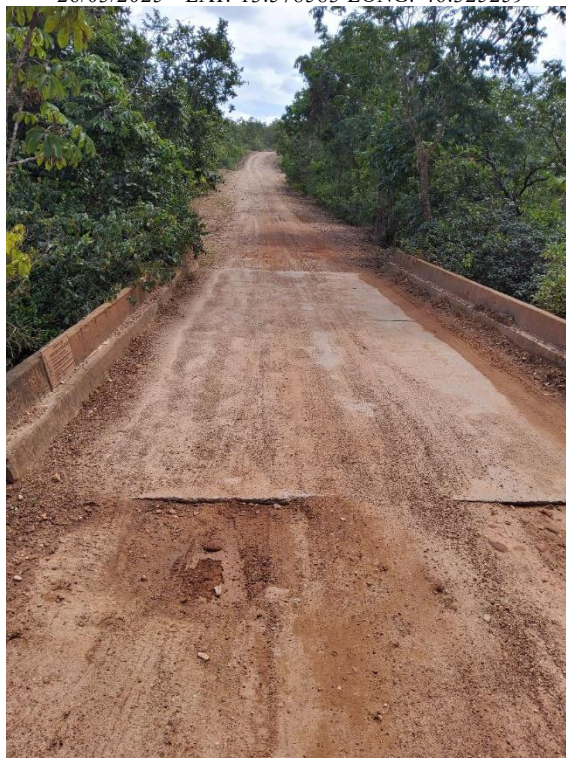
Foto 18 – Ponte Mista – km 20,3.
