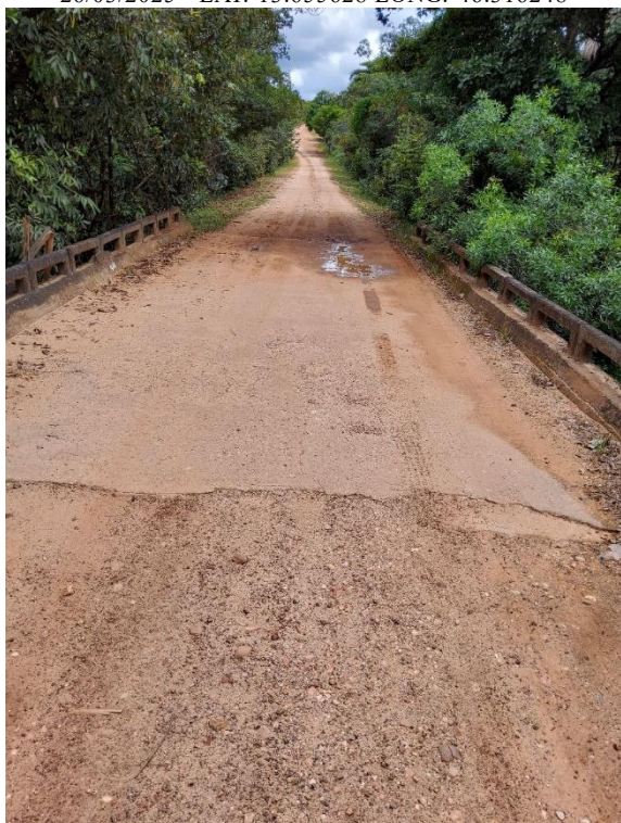
Foto 7 – Ponte Mista – km 10,5.
