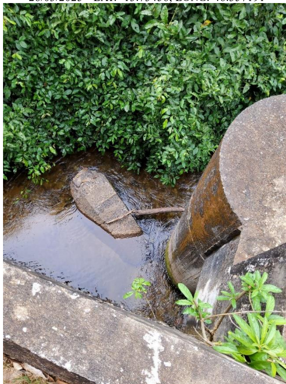
Foto 2 – Início do trecho (PCA) – km 0,0.
