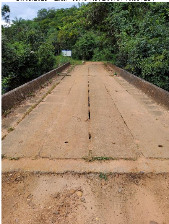
Foto 1 – Início do trecho (PCA) – km 0,0.
