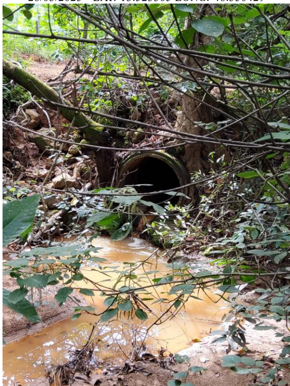
Foto 23 – Bueiro tubular – km 20,3.
