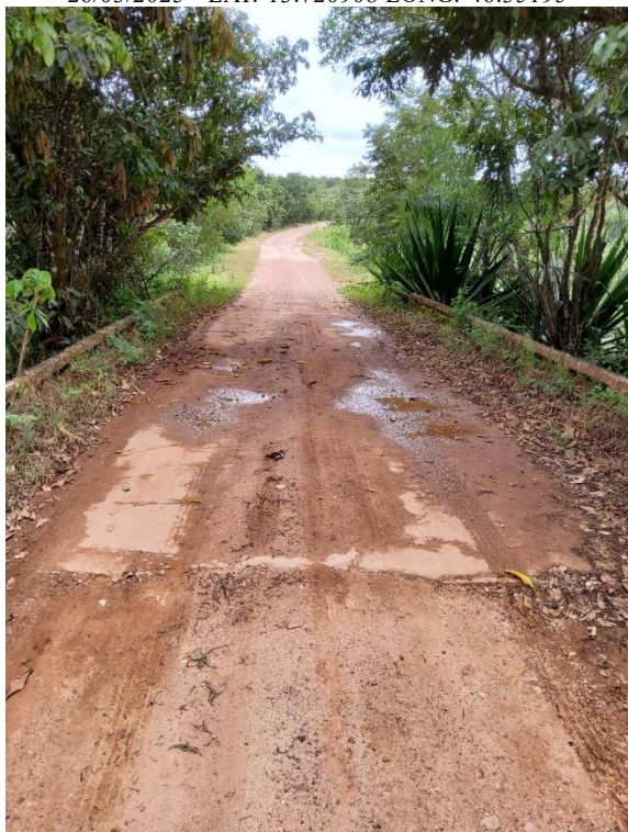
Foto 5 – Ponte Mista – km 1,7.
