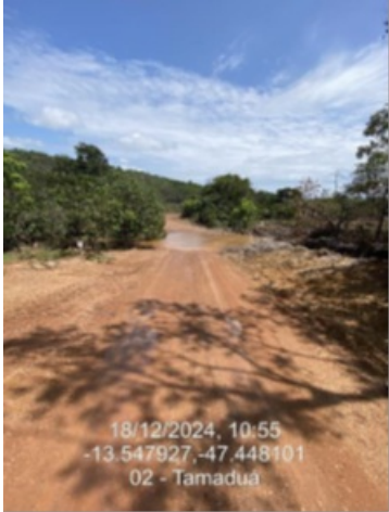
Ponto 2 – Ponte de madeira
