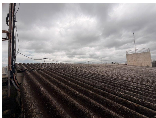
Foto 20: Sistema de Proteção Contra Descargas Atmosféricas.
