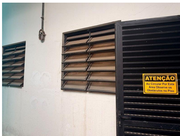
Foto 4: Área de acesso a casa de máquinas elevador
