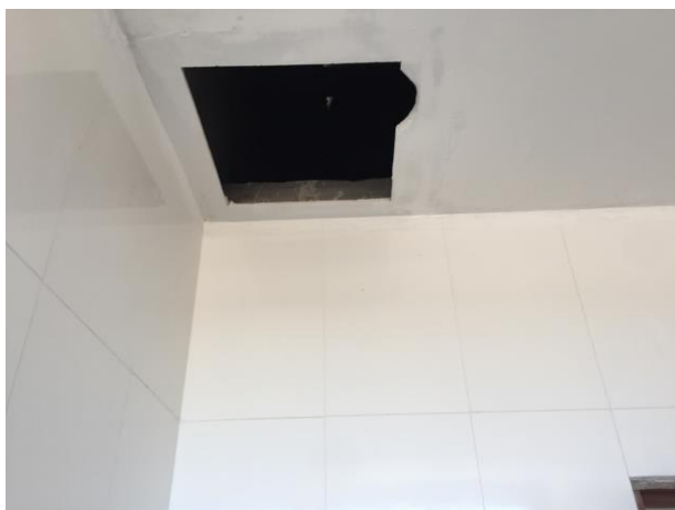
Alçapão do forro de gesso
