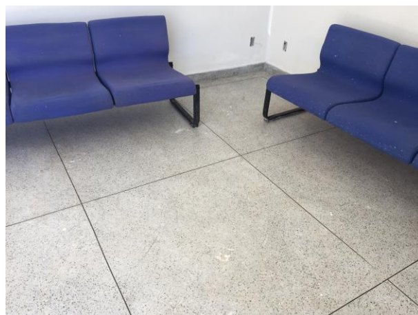
Limpeza piso de granitina
