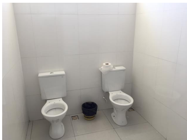
Divisórias e portas dos banheiros
