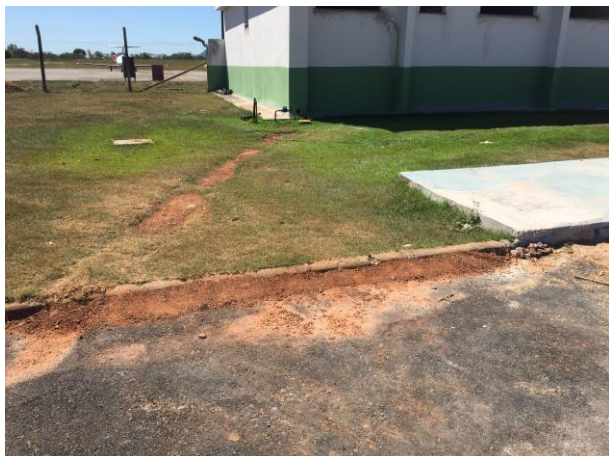
Rampa de acesso e calçada
