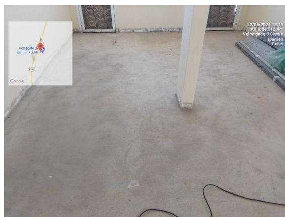
Piso sala de embarque
