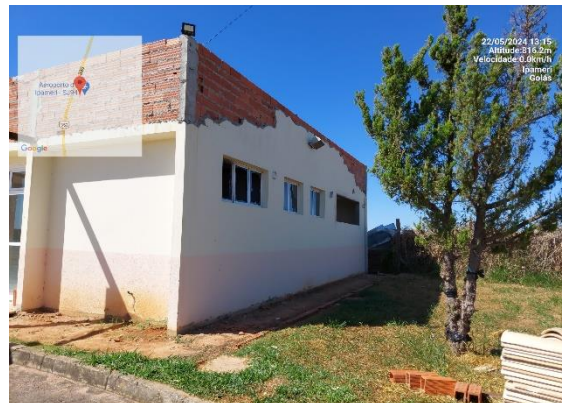
Fachada lateral direita
