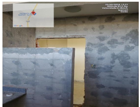
Sanitário feminino - porta
