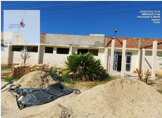
Platibanda e abrigo caixa d'água
