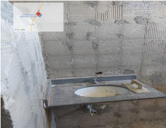
Sanitário masculino – bancada
