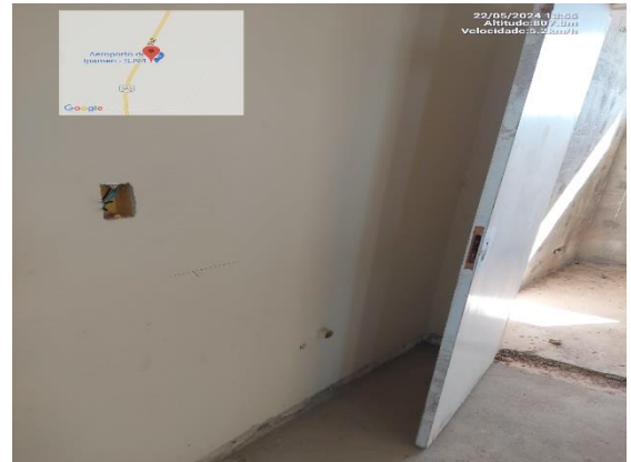
Contra piso para cerâmica
