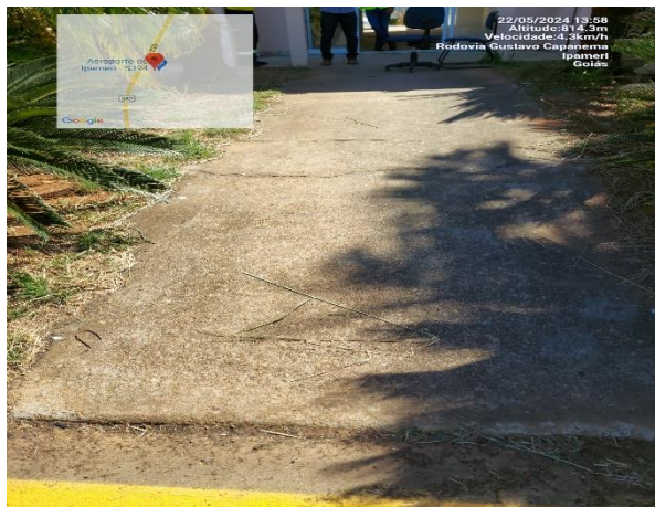
Calçada acesso pista
