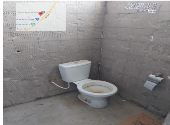
Sanitário sala administração
