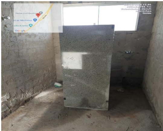
Sanitário masculino – divisórias
