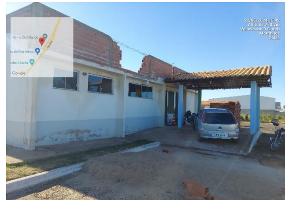
Platibanda e abrigo caixa d'água
