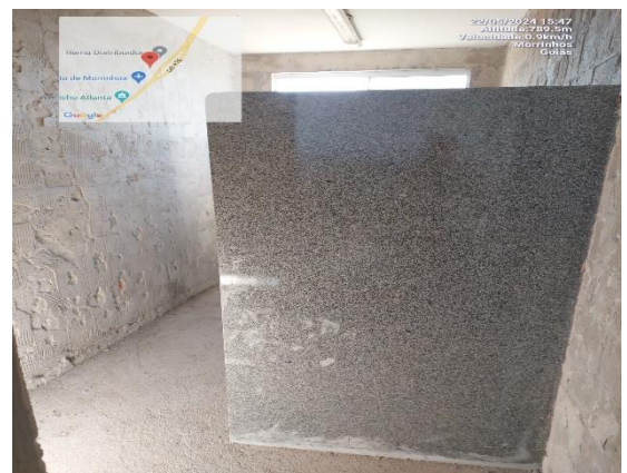
Sanitário feminino - porta
