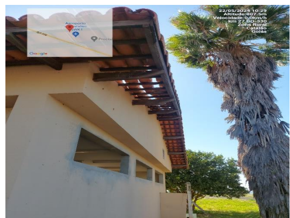
Reparo telhado lateral direita
