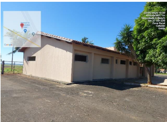
Fachada lateral esquerda
