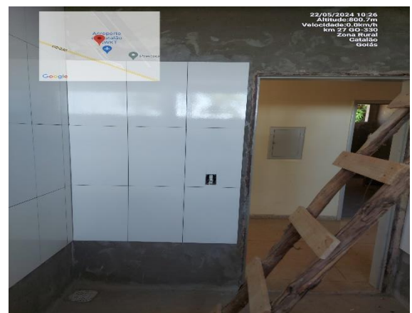
Sanitário feminino – porta
