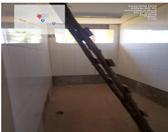
Sanitário feminino - janela
