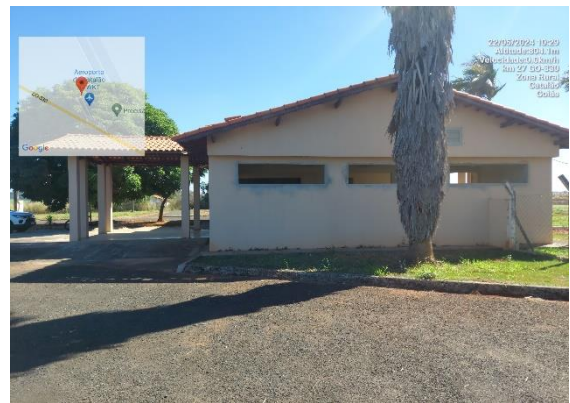
Fachada lateral direita
