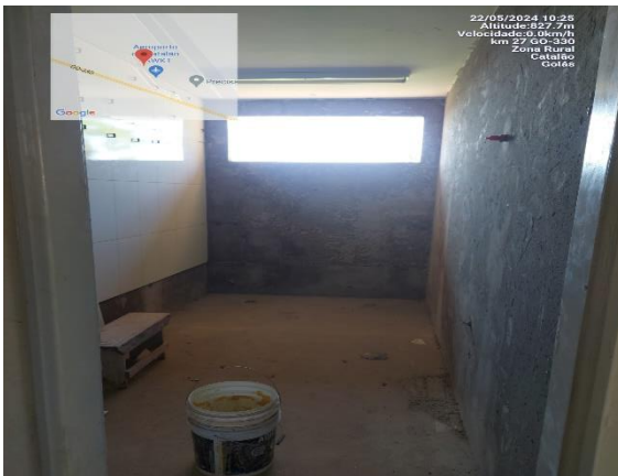
Sanitário masculino – janela
