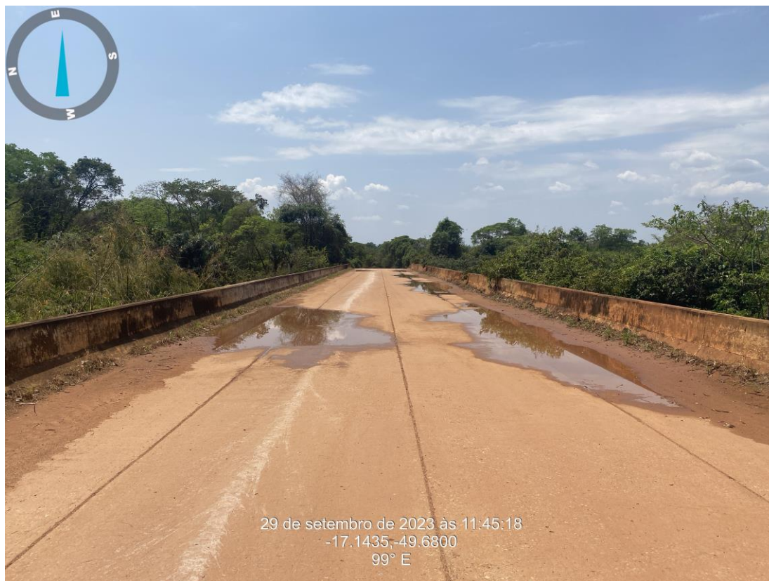
Km: 2,60 – Ponte em Concreto Armado – 81,5 x 8,5
