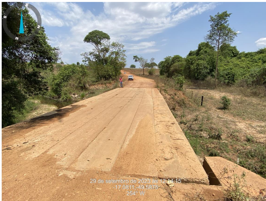
Km: 15,20 - Ponte em Concreto Armado – 18,20 x 5,60.
