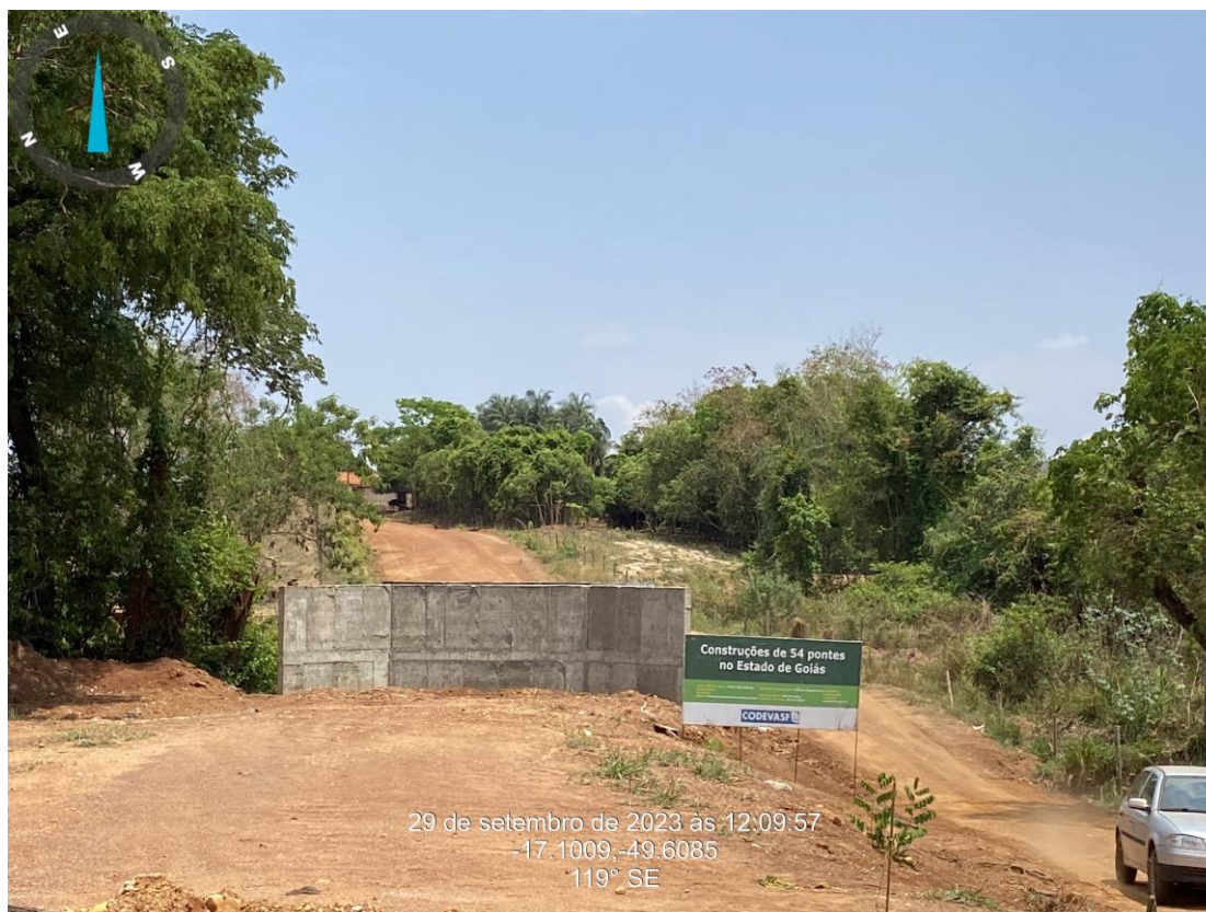
Km: 12,00 – Ponte em Concreto Armado - construção.
