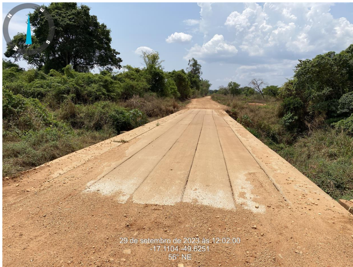
Km: 10,00 – Ponte de Concreto Armado 36 x 5,60.
