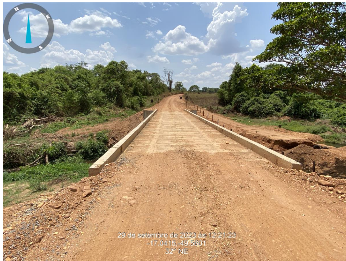
Km: 21,10 – Ponte em Concreto Armado – 24,10 x 4,10.
