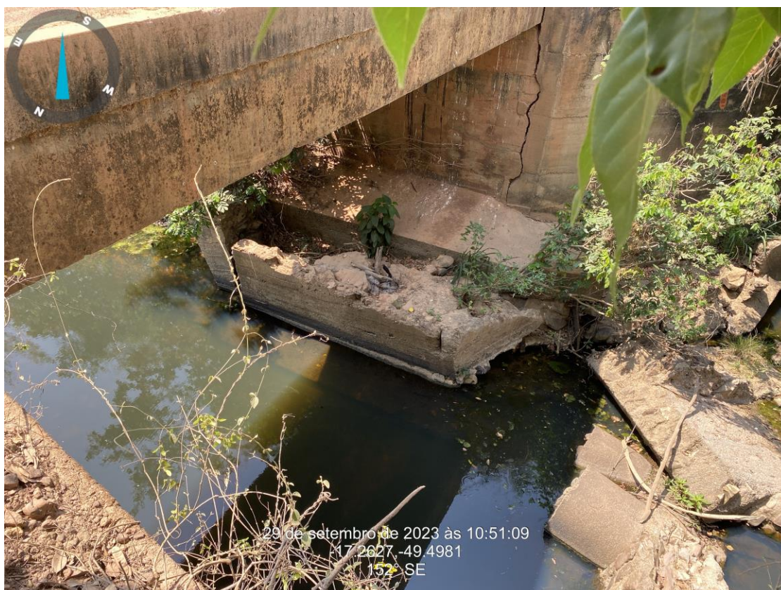
Km: 33,90 – Ponte em Concreto Armado.
