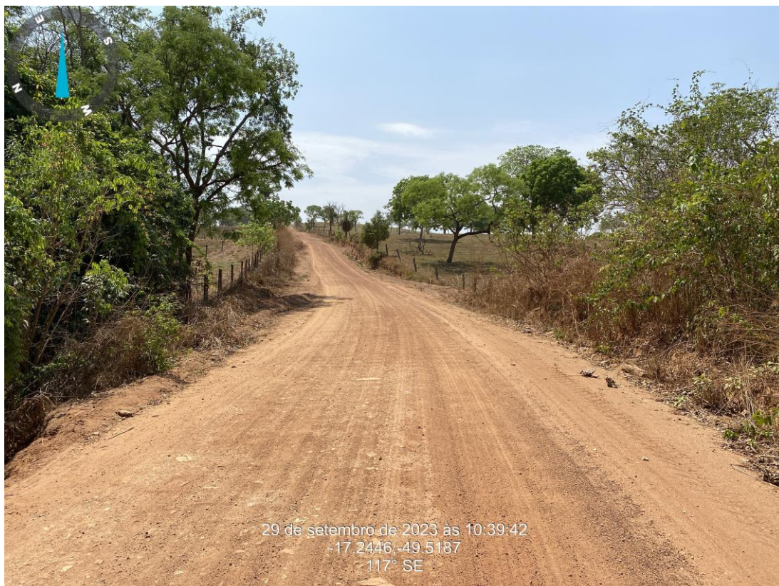
Km: 29,9 – Bueiro tubular.
