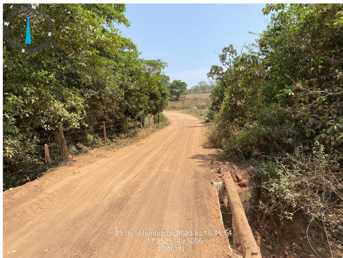
Km: 32,20 – Ponte de Madeira.
