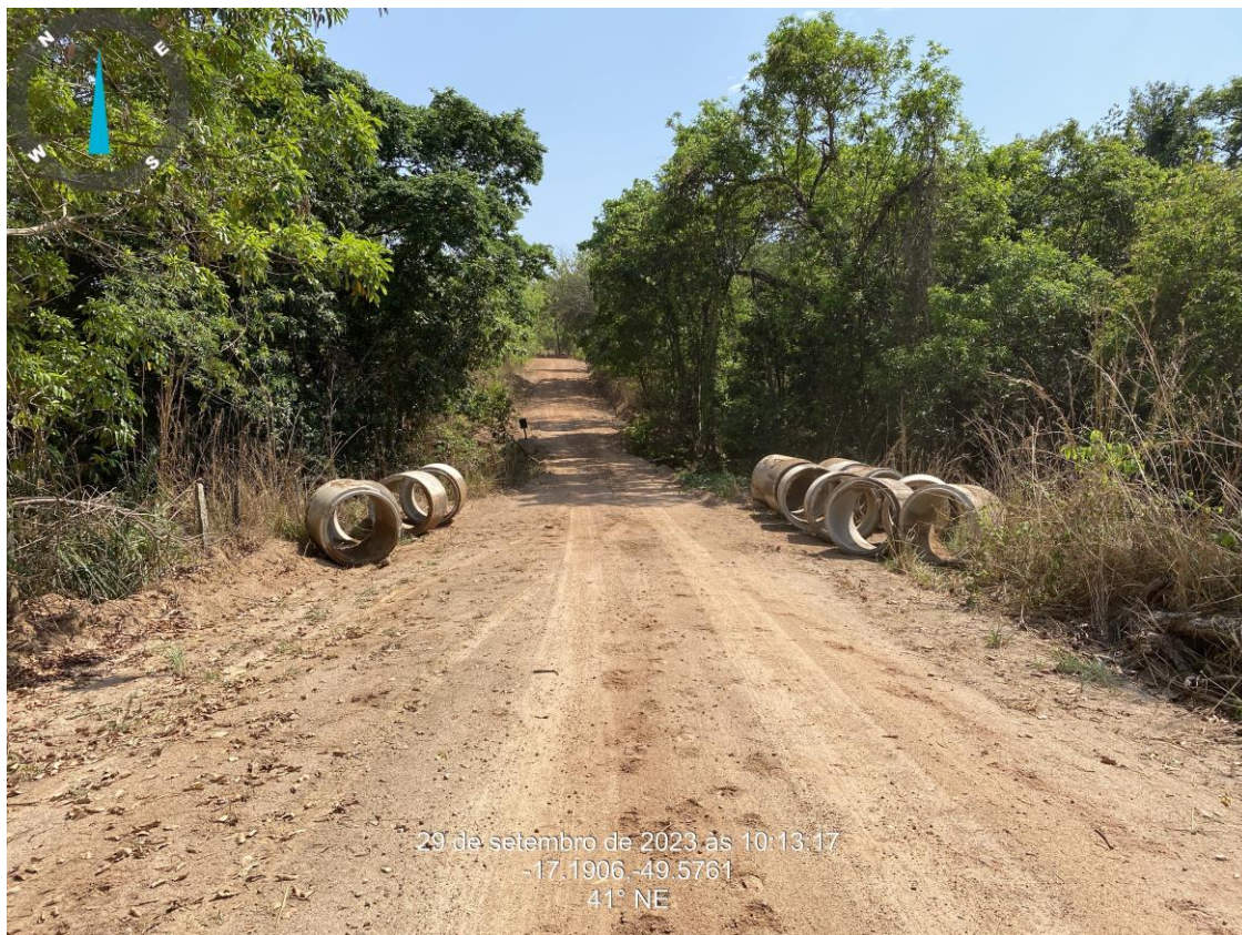
Km: 19,10 – Ponte de Madeira.
