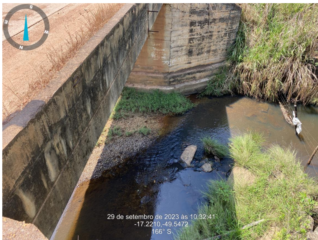
Km: 25,50 – Ponte em Concreto Armado 10x4,5.
