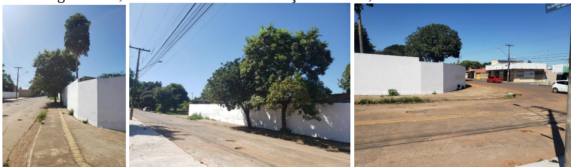
Fotografias 09 e 10 – Vista salas de aula bloco 1;
