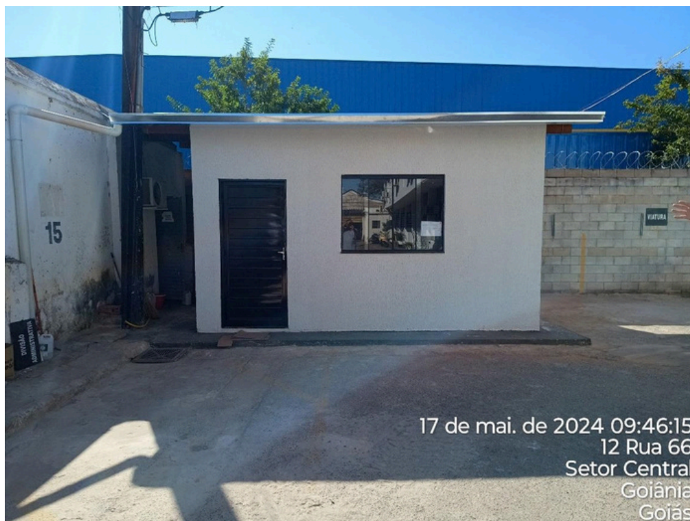
Figura 6: Ampliação sala dos motoristas
