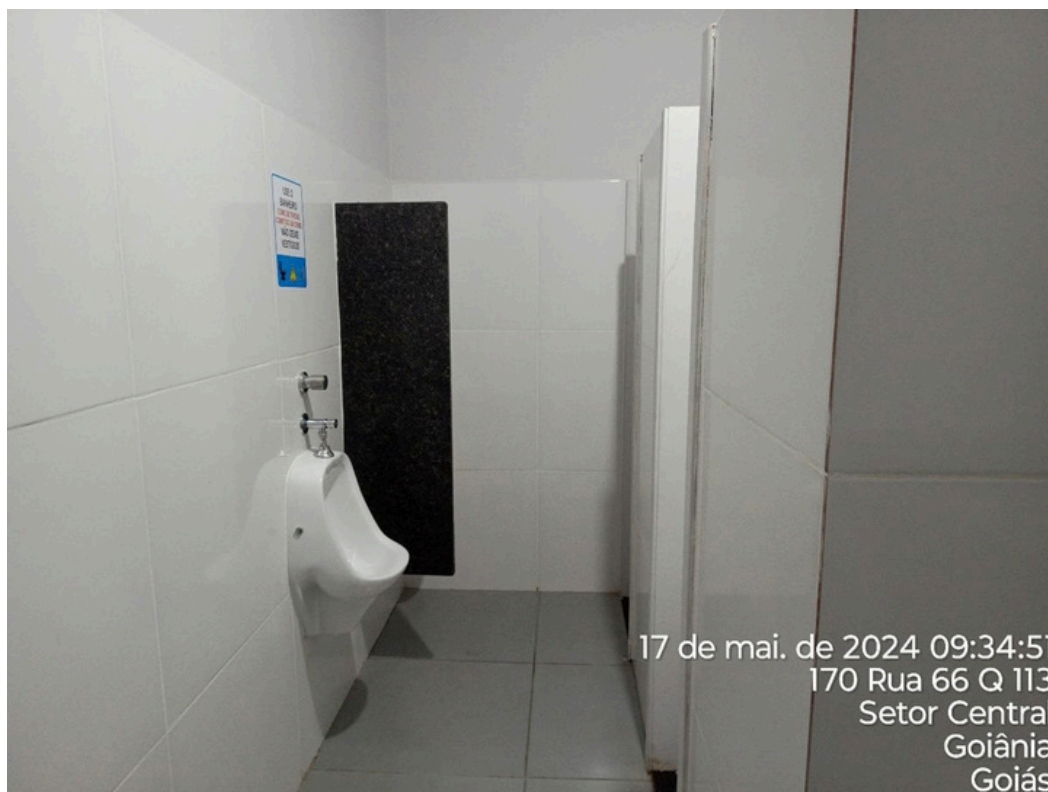
Figura 12: Banheiro WC-2 masculino piso térreo
