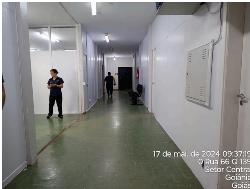
Figura 16: Pintura do corredor de acesso ao refeitório piso superior
