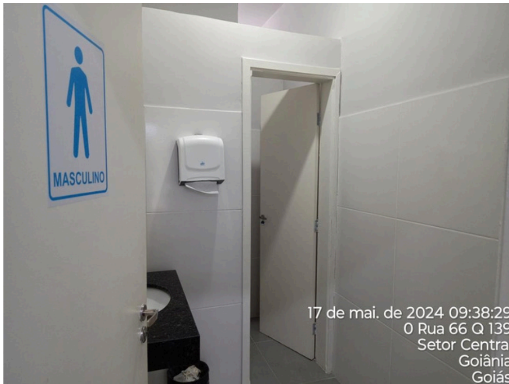
Figura 15: Banheiro WC-5 masculino piso superior
