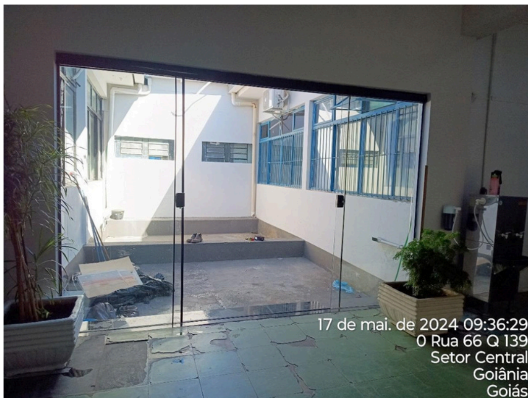
Figura 14: Porta de vidro acesso fosso piso superior
