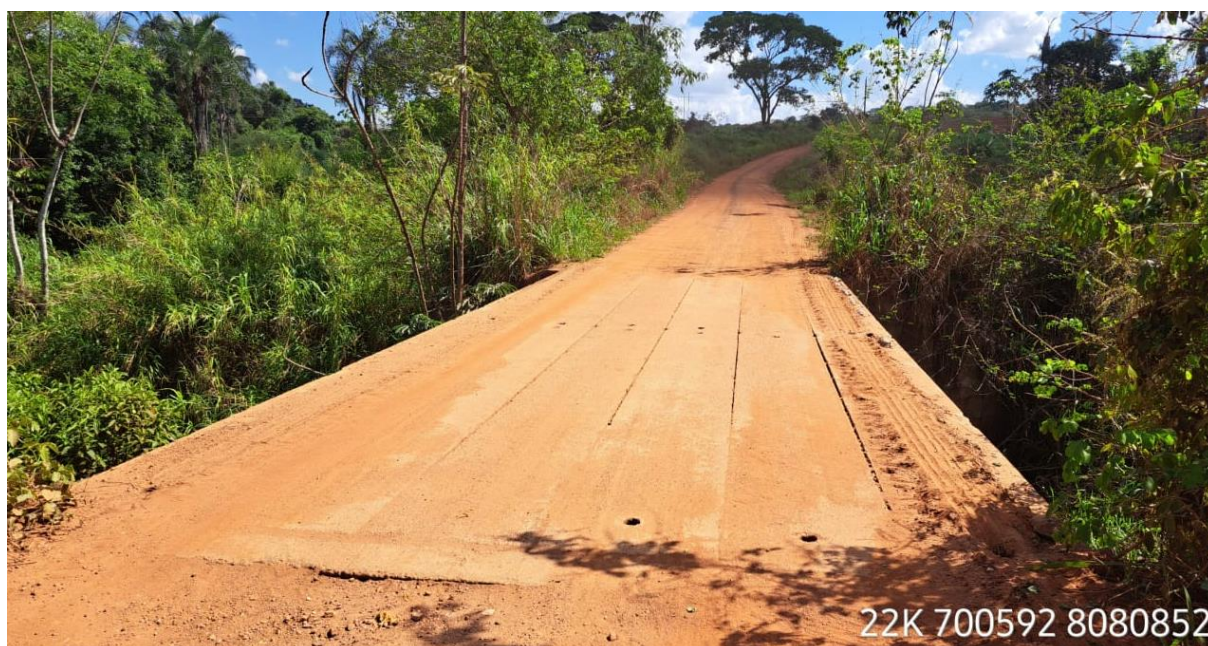
Km: 6,00 – Ponte em Concreto Armado - 13,00 x 5,00 de largura.
