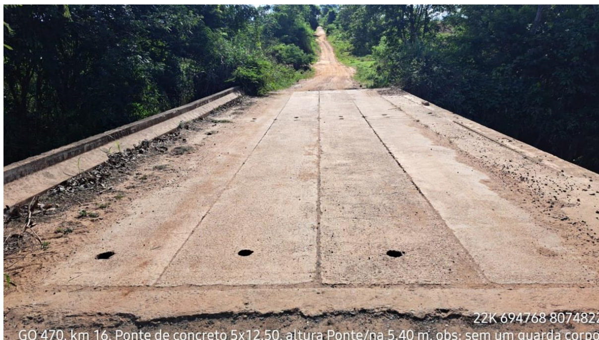
Km: 16,00 – Ponte em Concreto Armado 12,50 x 5,00 de largura.
