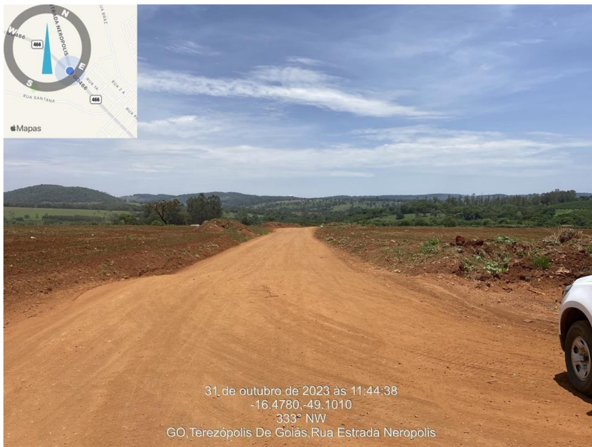
Km: 0,0 - GO-466, Trecho: Início Perímetro Urbano (Terezópolis de Goiás) - Entr. GO-080 (Vila Rica)
