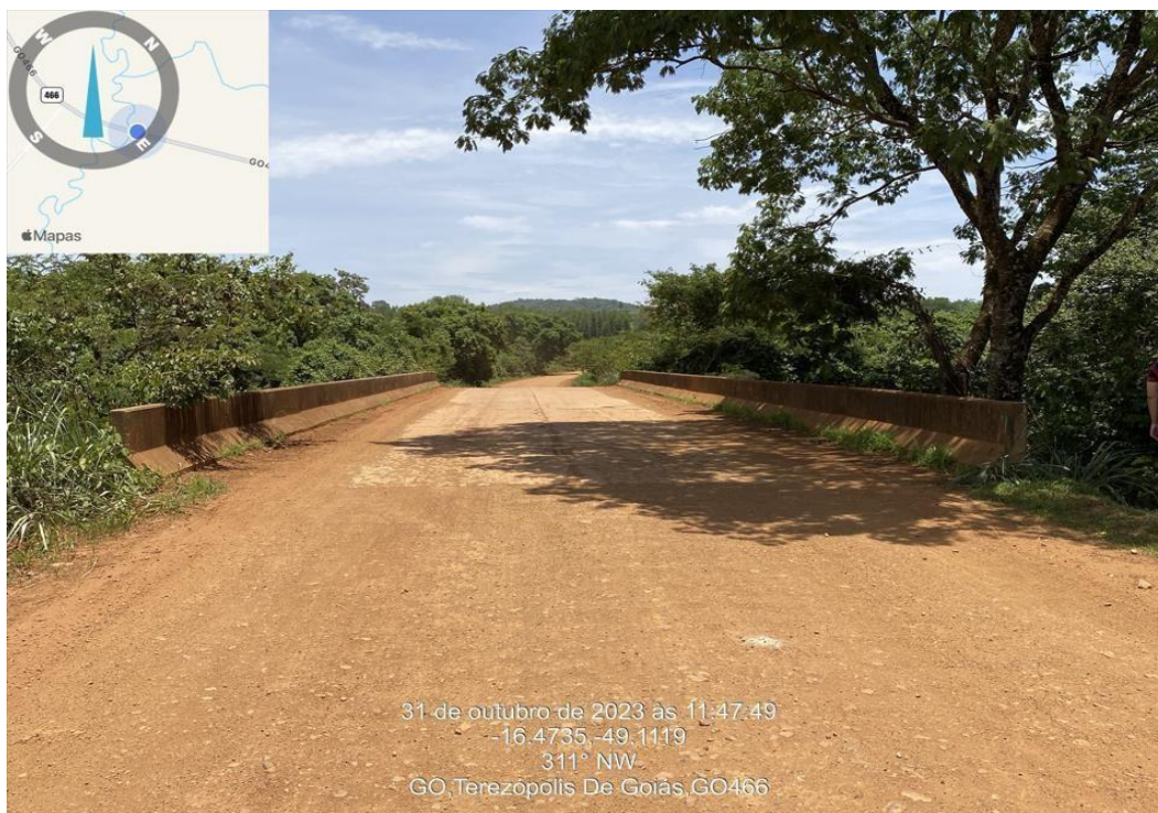
Km: 1,20 – Ponte em concreto armado – 40,00 x 8,00 de largura.
