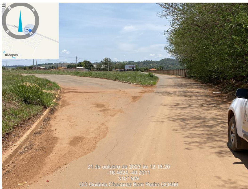
Km: 12,56 – Final - Perímetro Urbano (Terezópolis de Goiás) - Entr. GO-080 (Vila Rica)
