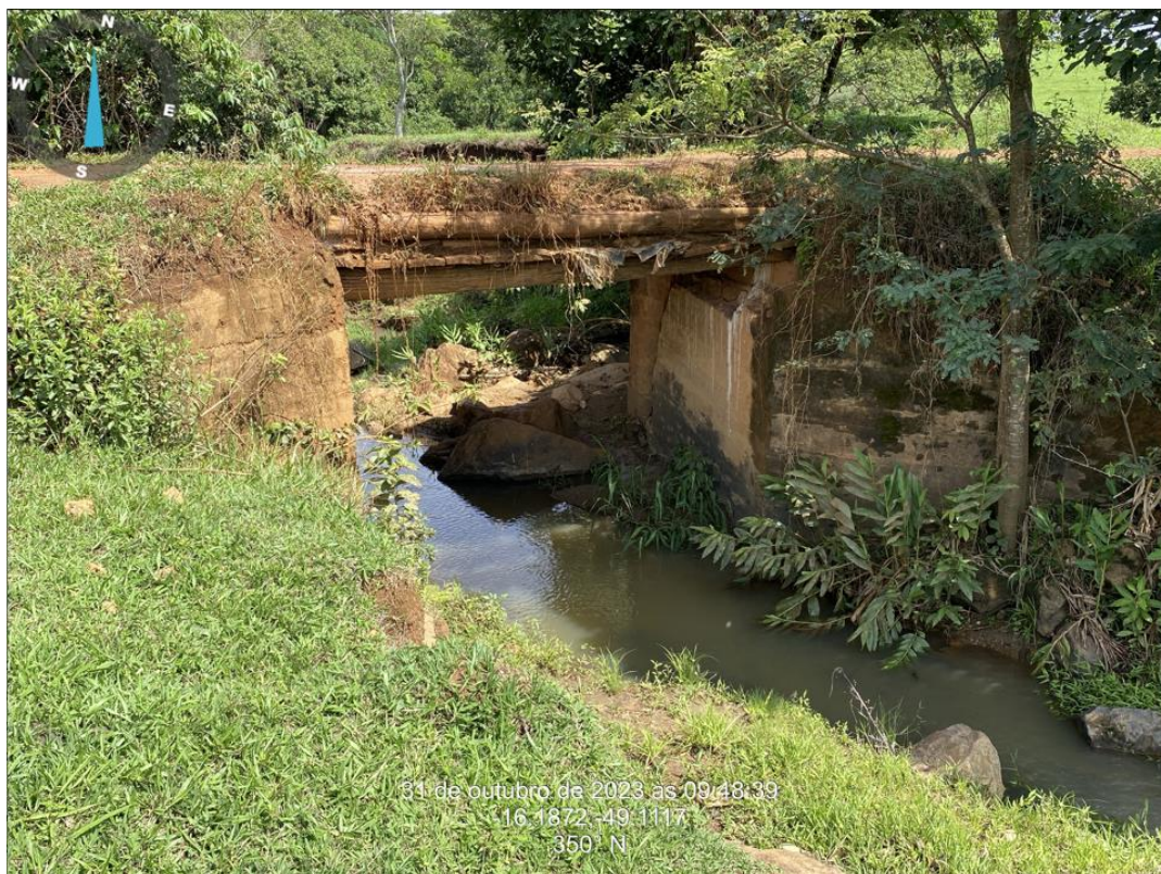
Km: 12,10 – Ponte de madeira.
