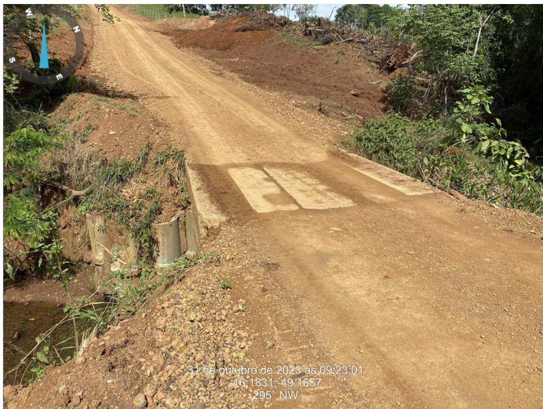
Km: 5,20 – Ponte em concreto armado – 4,5 x 3,60 largura.
