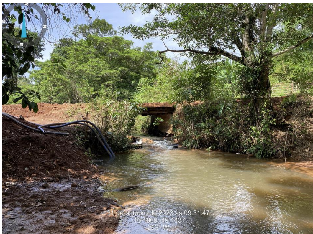
Km: 8,00 – Ponte de Madeira.
