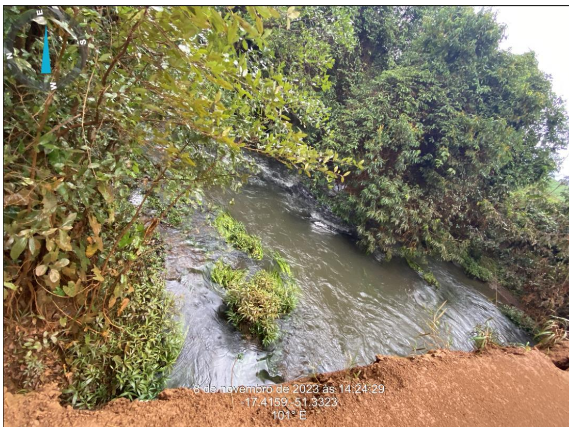
Km: 2,10 – Ponte de Madeira.
