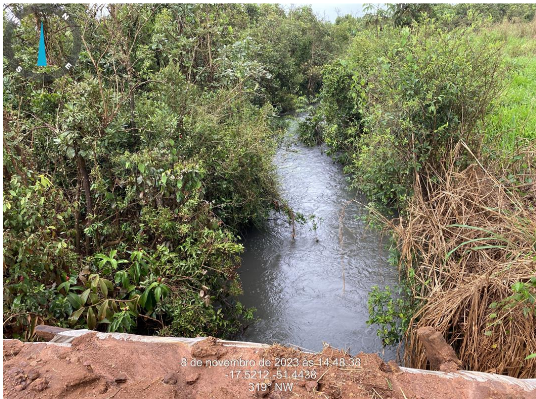
Km: 21,60 – Ponte de Madeira.
