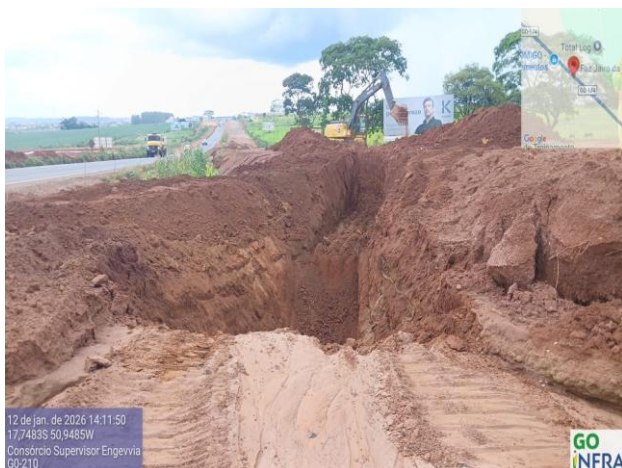
Escavação corte na diagonal na estaca 7 pista Id esquerdo retorno 2 propósito minimizar surgimento de erosões
