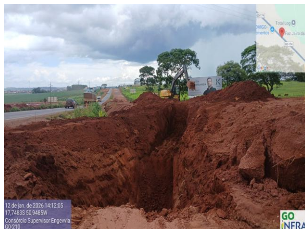
Escavação corte na diagonal na estaca 7 pista Id esquerdo retorno 2 propósito minimizar surgimento de erosões
