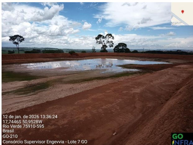
Escavação corte na diagonal na estaca 7 pista Id esquerdo retorno 2 propósito minimizar surgimento de erosões
