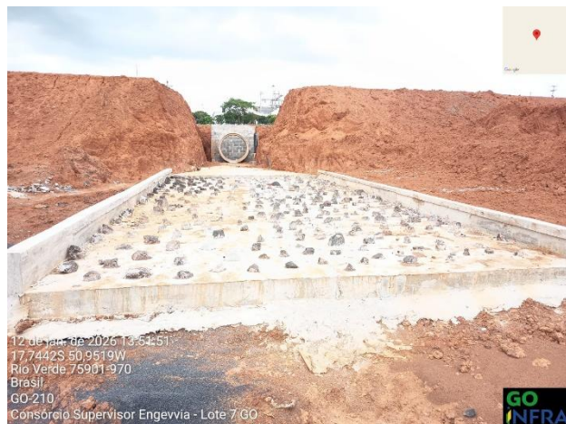
Escavação corte na diagonal na estaca 7 pista Id esquerdo retorno 2 propósito minimizar surgimento de erosões
