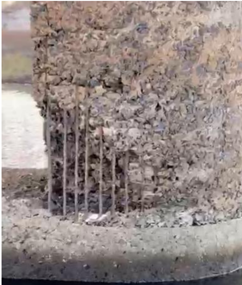
Figura 4 – Pilar danificado
