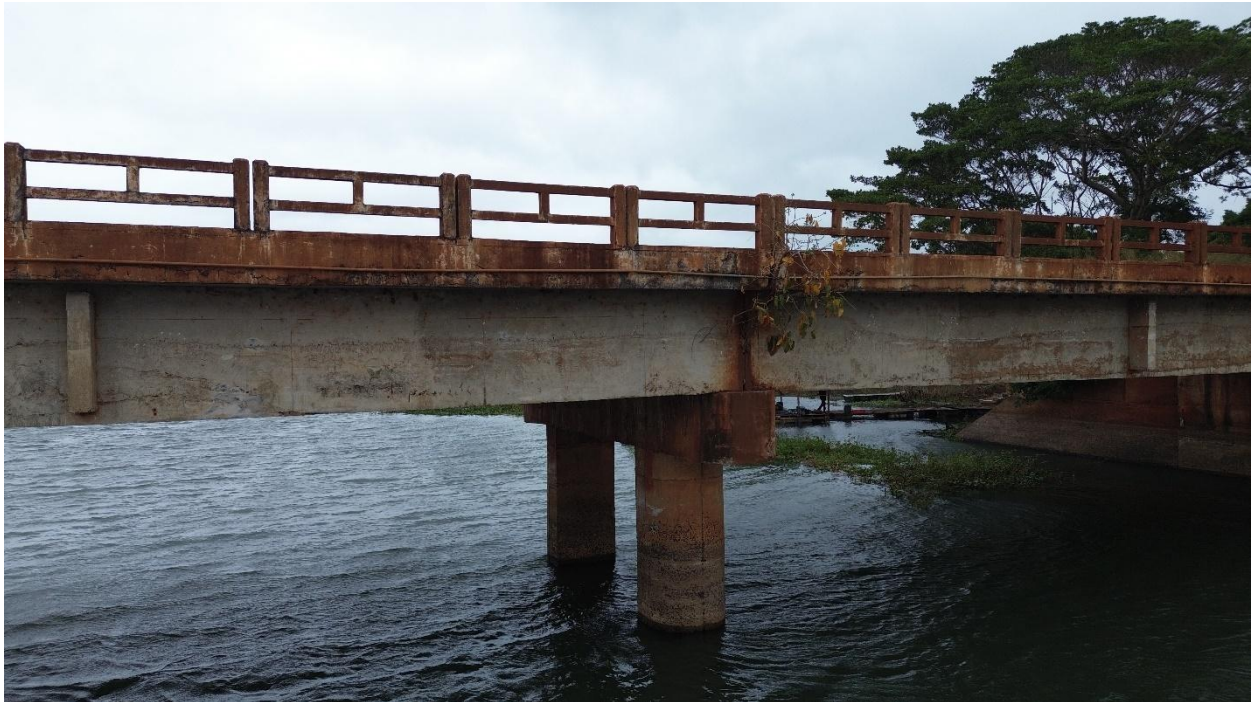
Figura 2 – Vista lateral de um trecho da OAE
