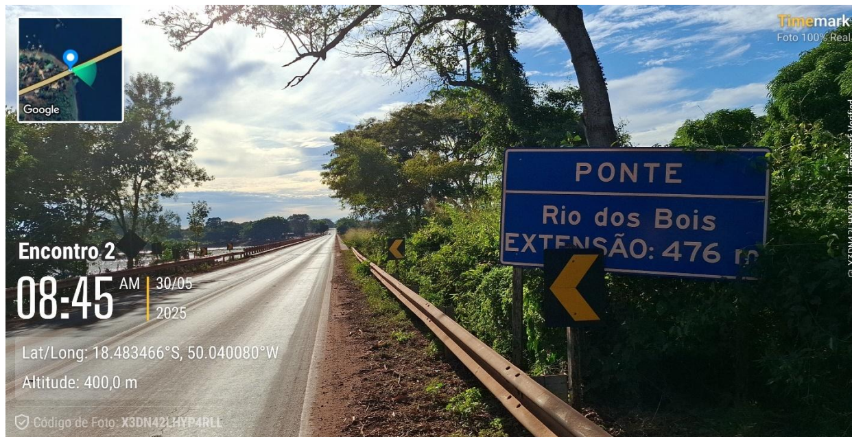
Figura 1 – Vista superior da OAE
