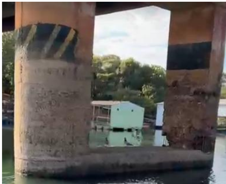
Figura 3 – Pilar danificado
