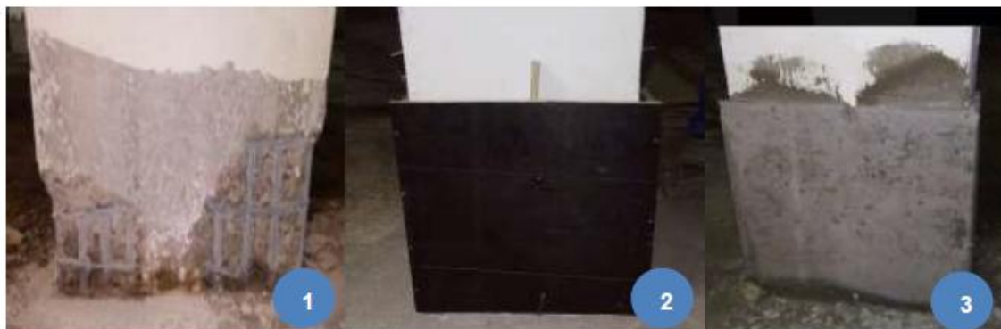
Figura 12 – Processo de recuperação do pilar – (1) Pilar existente, (2) Formas, (3) Seção final
